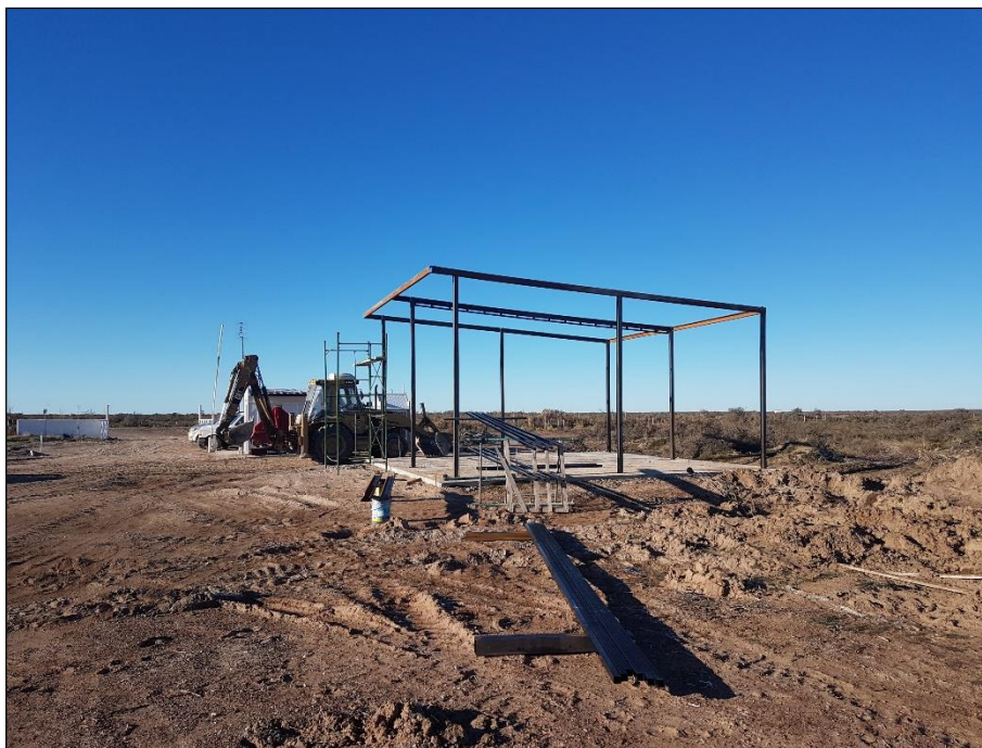
Foto 5 - Vista del galpón en construcción.
