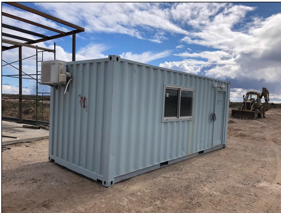
Foto 6 - Vista externa de oficina.
