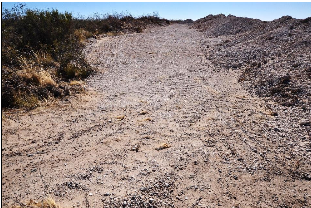
Foto 8 - Trinchera rellena y cubierta.
