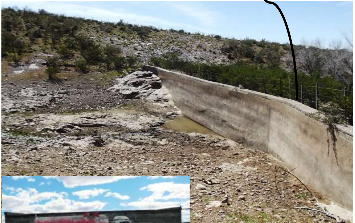
Foto 7 y 8. Dique de cemento para retener aguas de escorrentía en Establecimiento Don León
