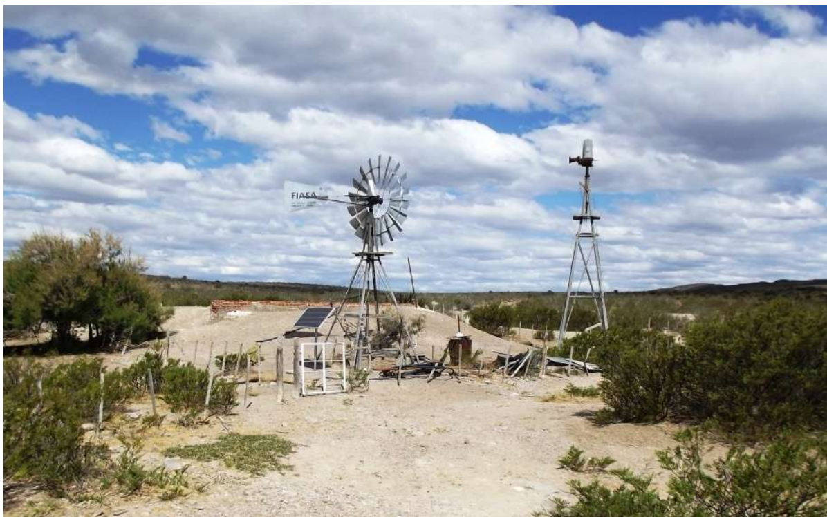
Fotos 10 y 11 – Tanques de distribución de agua. Los molinos han sido reemplazados por bombas eléctricas, alimentadas con paneles solares.
