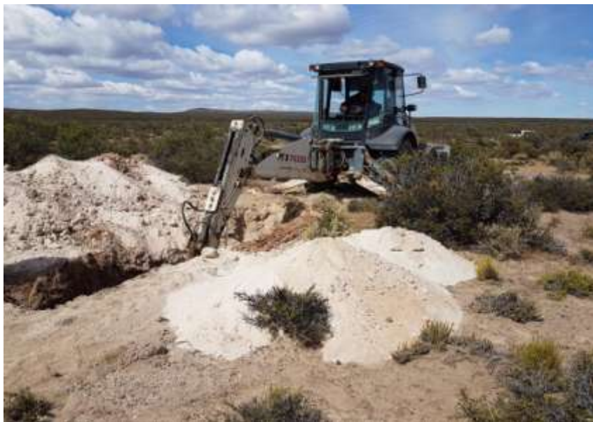
Foto 27 – Retroexcavadora TX 7608 realizando apertura de trinchera.
