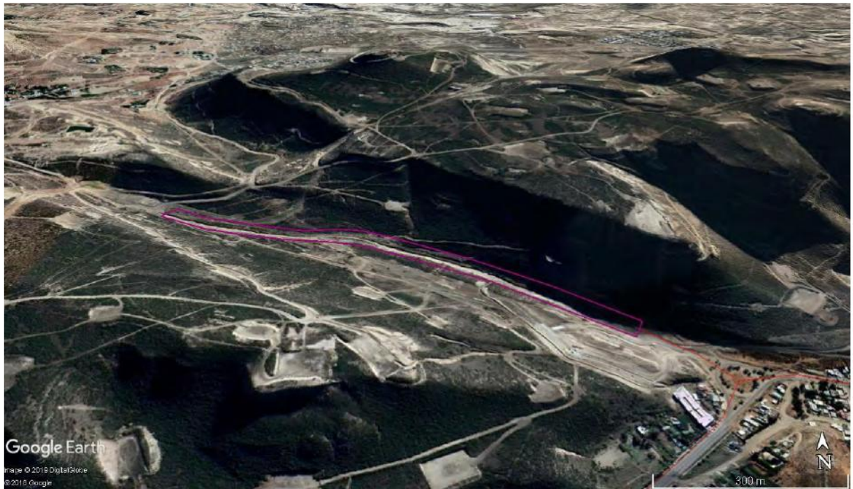
Figura 22: Imagen satelital obtenida de Google Eart Pro Digital Globe 2019 de camino alternativo a Barrio Laprida.
