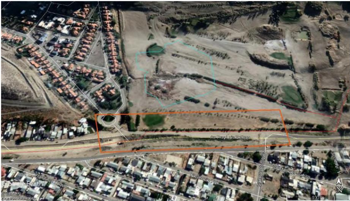
Imagen 49: Zona de futuro reservorio en predio del Club Santa Lucía.
