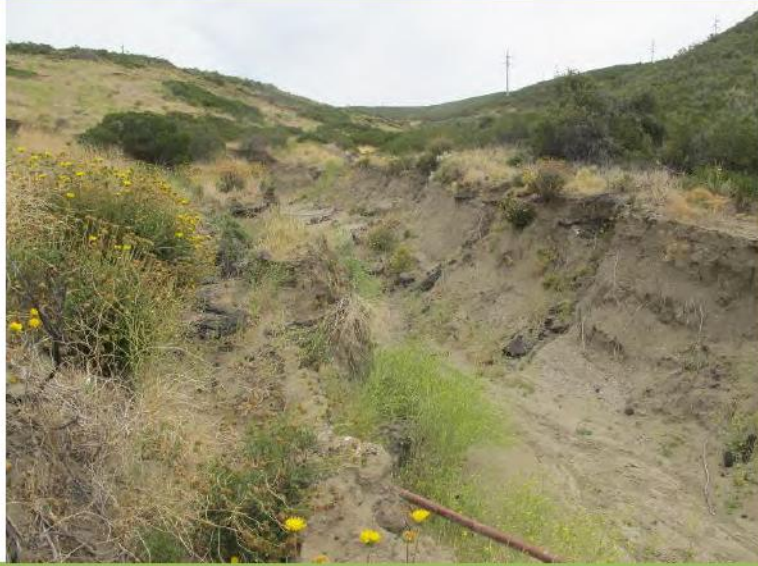
Imagen 43: Cauce temporal que desemboca a la zona del reservorio.
