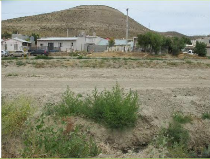
Imagen 32: Vista de la Calle F.L. Beltrán. en zona donde se han iniciado maniobras de relleno del canal generado como consecuencia de la tormenta del año 2017. Vista en dirección Sur. Ubicación: 45°50'22.07"S 67°29'56.68"O
