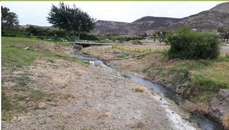
Imagen 31: Vista hacia el Oeste desde la desembocadura del futuro del canal revestido de sección trapecial de actual escurrimiento por terreno en la progresiva 1025.96. Se observa interior del Club de golf Santa Lucía.
