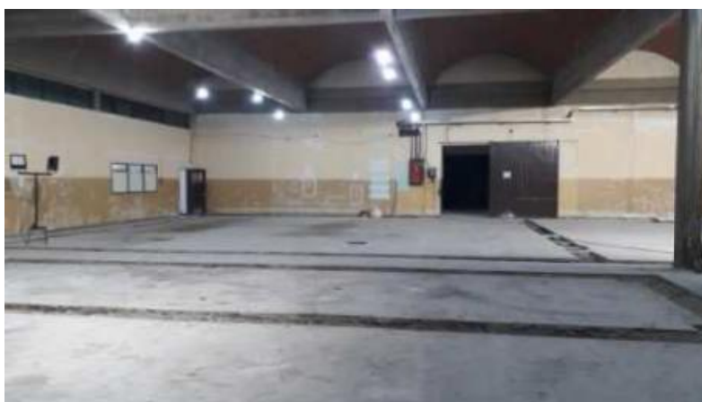
Imagen 4: vista interior de uno de los sectores de la planta a rehabilitar
