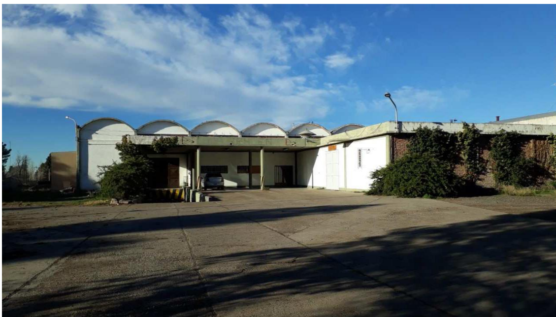
Imagen1: Vista del acceso principal del establecimiento a rehabilitar donde operará Patagonian Sea Secret (PSS)
