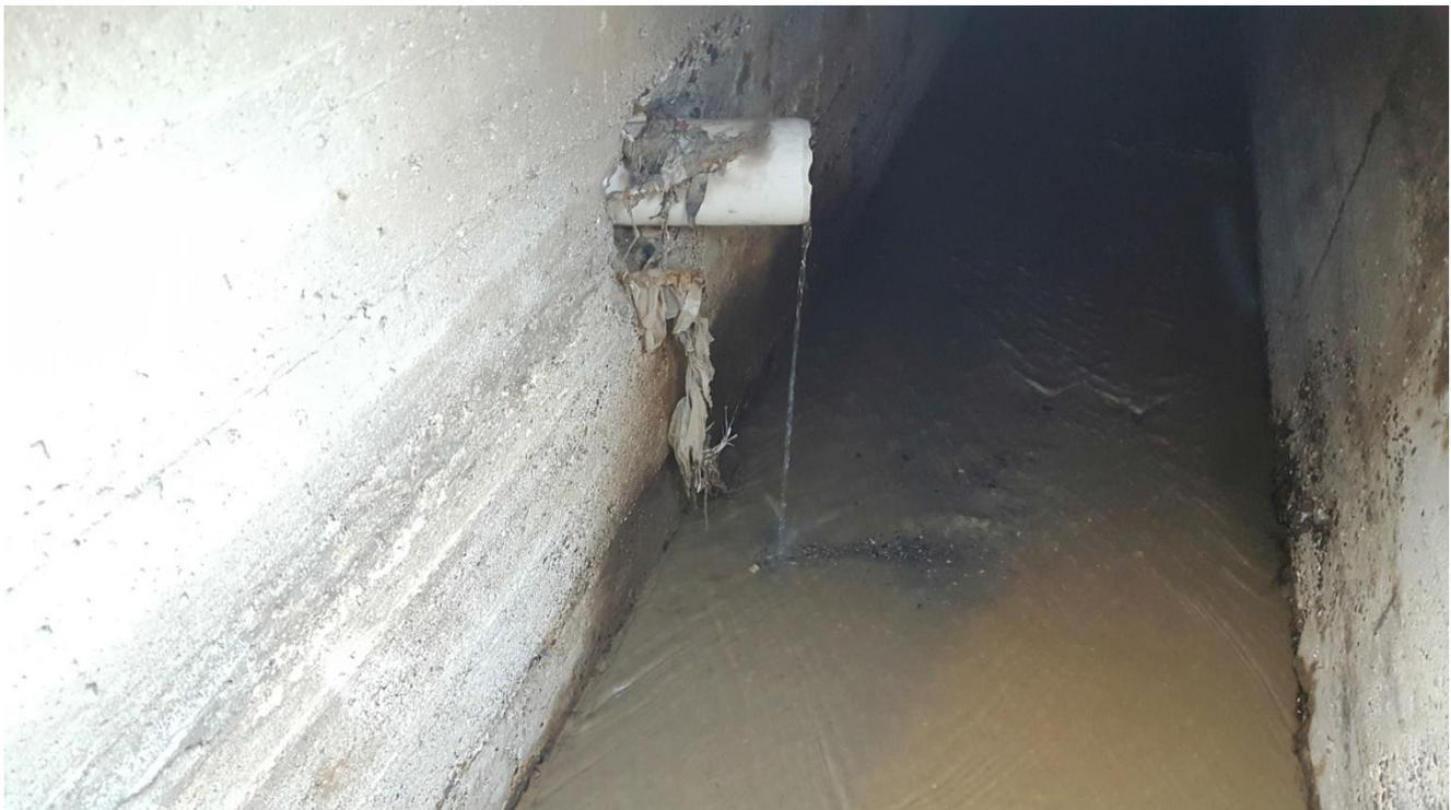
Descarga cloacal de casa particular a conducto pluvial
