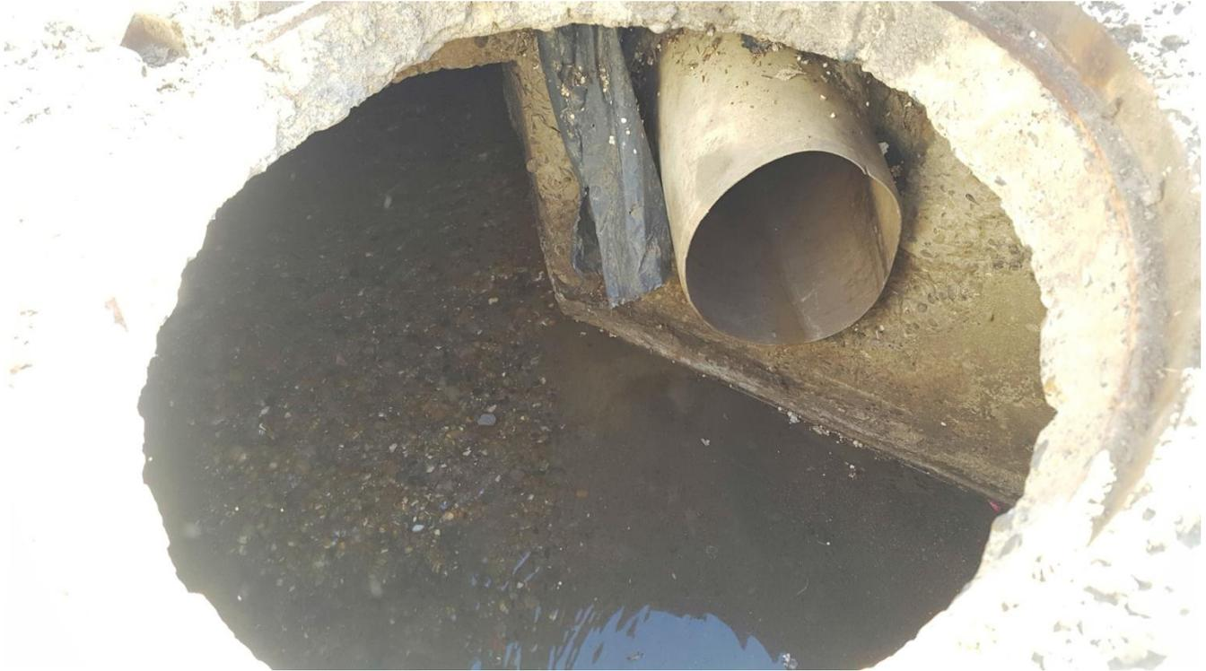
Caño de  $\varnothing$ 160mm desde red cloacal a conducto pluvial
