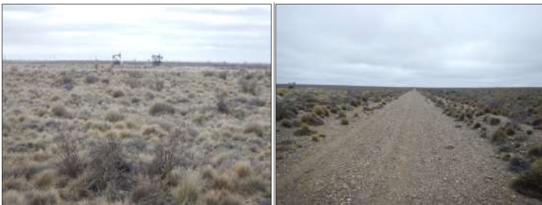
Fotografías 27 y 28. Vistas de instalaciones petroleras varias y Gasoducto Gral. San Martin
