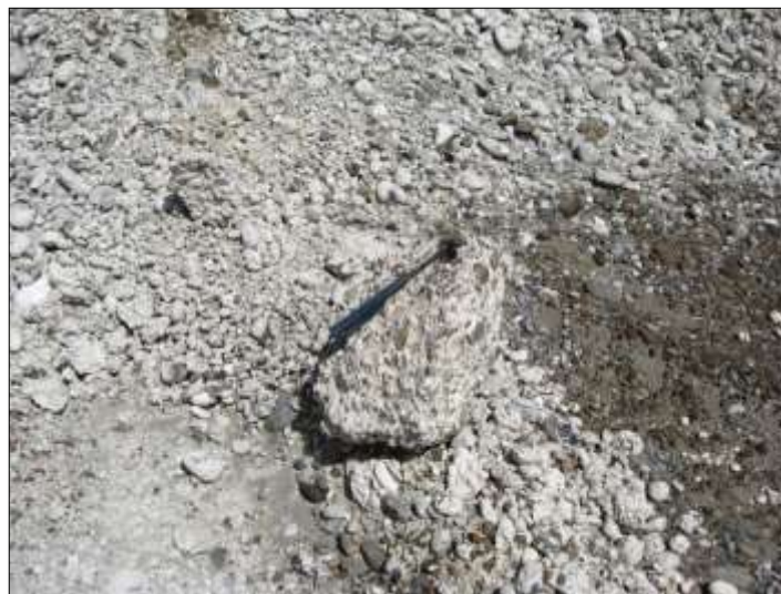
Fotografía 5. Bloque de ortoconglomerado desprendido de la pared, que se encuentra fuertemente cementado por la presencia de precipitados carbonáticos de aspecto terroso. Escala mango de piqueta: 30 cm.
