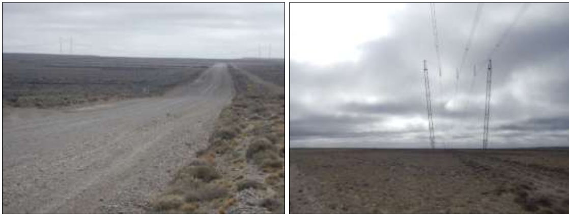
Fotografías 47 y 48. Vistas de la RP N° 37 (lateral O) y LEAT 500 kV
