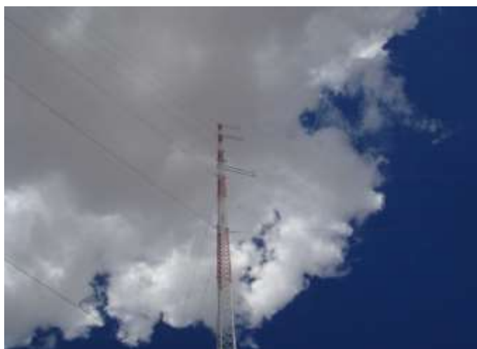
Fotografía 1. Torre de medición anemométrica.
