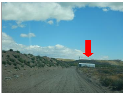
Galpón en predio lindero a la cantera
