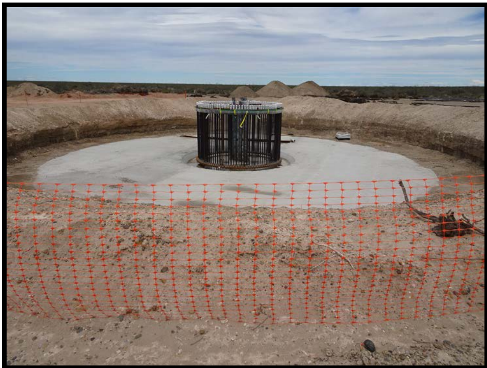
FOTO N° 2: Base de una torre de molino
