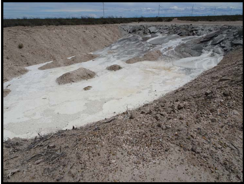
FOTO N° 15: Vista general de la C5
