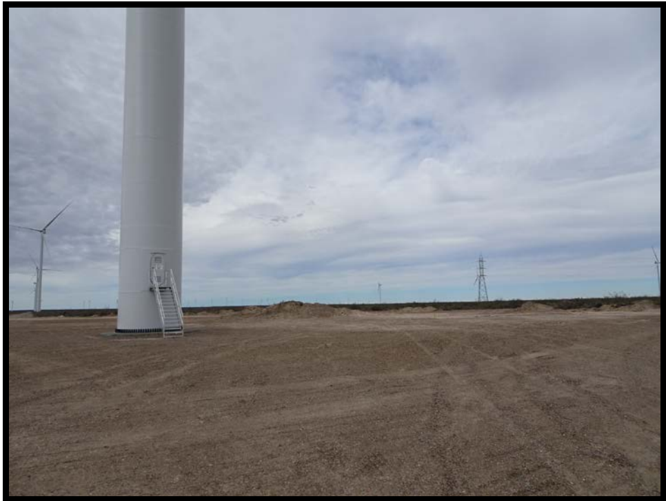
FOTO N° 3: Area cortafuego de molino
