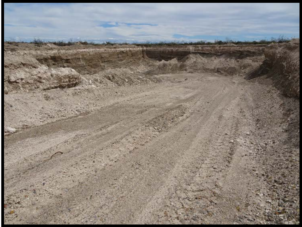
FOTO N° 17: Vista general de la C6
