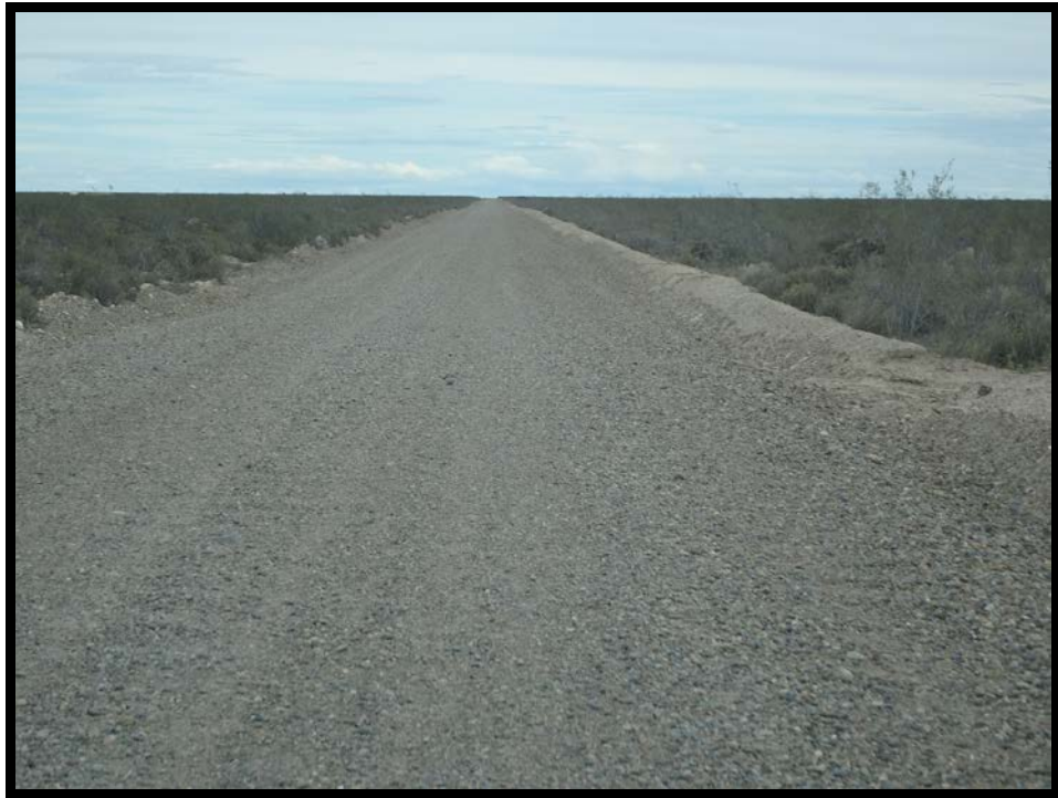
FOTO N° 1: Vista de camino interno consolidado. Red vial principal
