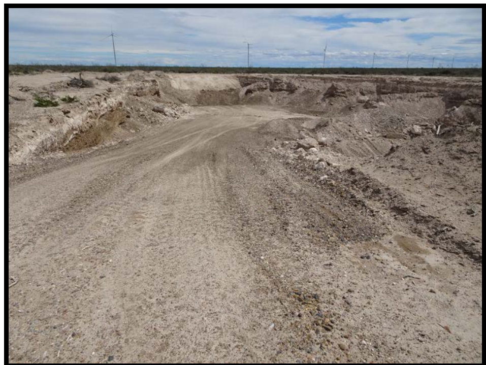
FOTO N° 14: Vista general de la C4
