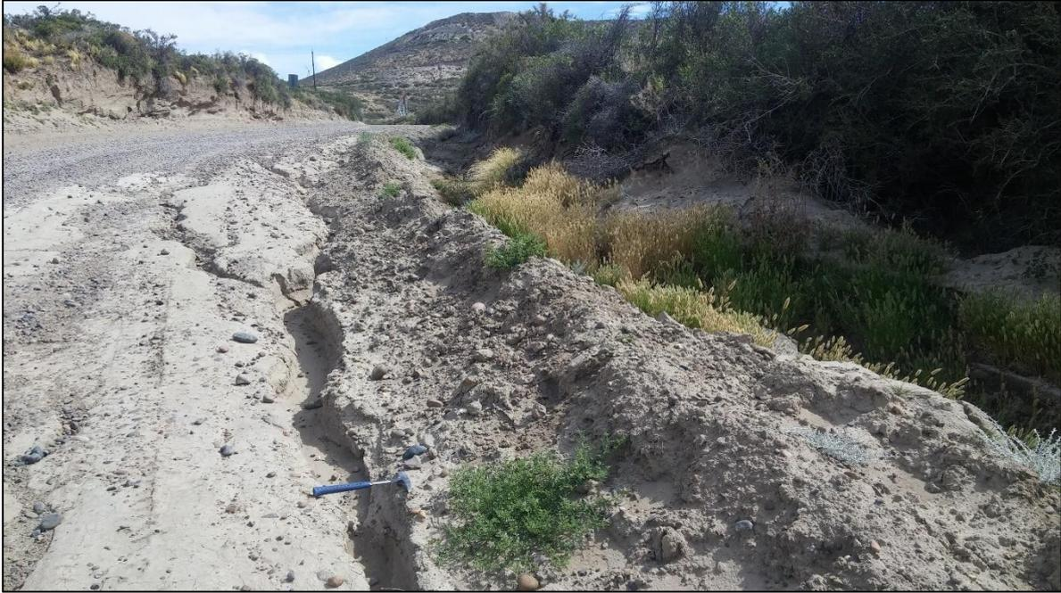
Foto 9: Ejemplo de escurrimientos superficiales y erosión hídrica.
