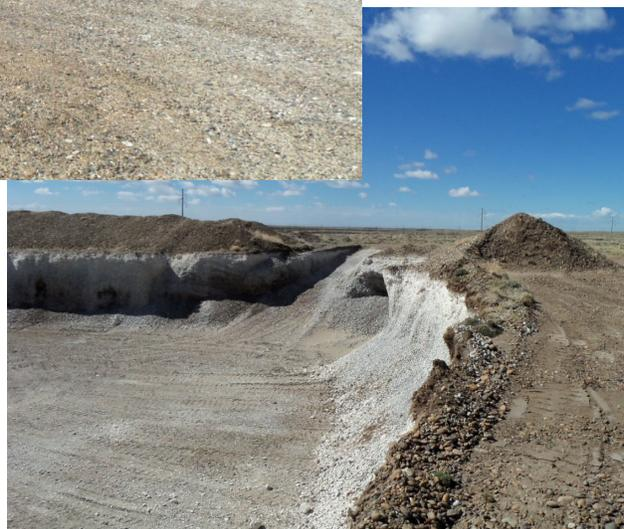
El destape es concentrado sobre uno de los laterales de la cantera, para ser usado posteriormente en las tareas de restitución de talud.
