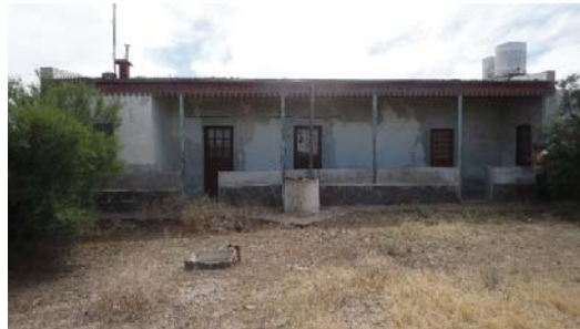
Vista de la casa a refaccionar.
