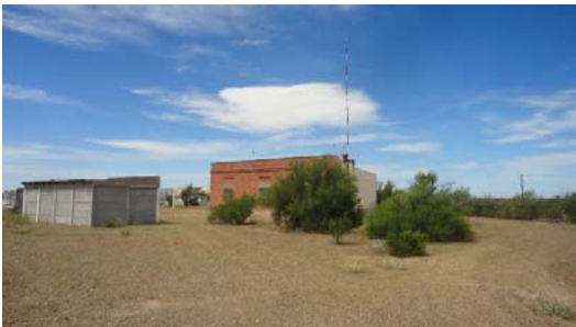
Vista posterior de la casa a refaccionar.
