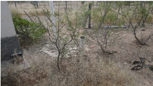
Pozo absorbente de la casa.
