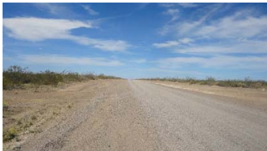
Vista de RP 4 desde acceso hacia el este.
