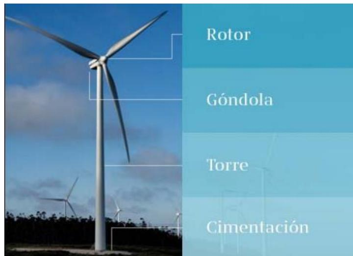
Figura 2: Principales componentes del aerogenerador (Góndola, Aspas y Torre).
