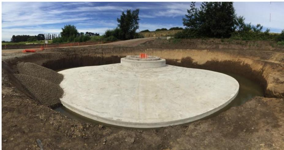
**Fotografía 1:** Fundación de un aerogenerador (Fuente: Enel)
