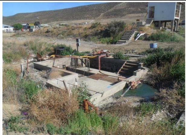
Foto 4 - Estación elevadora de efluente crudo
