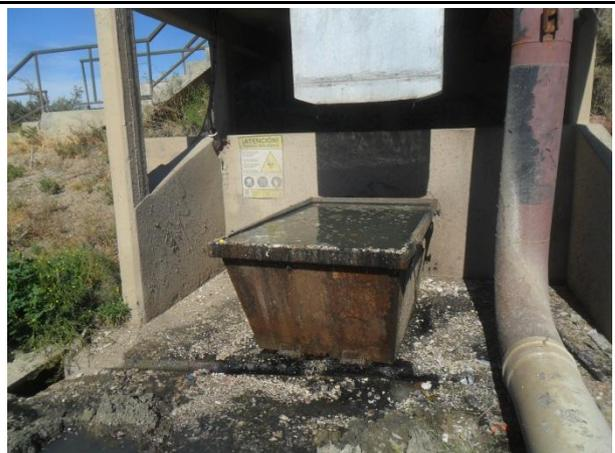
Foto 10 - Batea colectora del remanente
