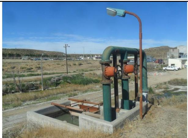
Foto 28 - Cámara partidora N°1 y aforo barro recirculado
