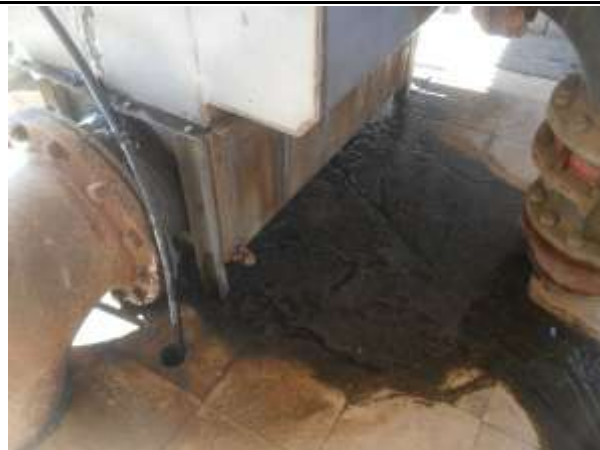
Foto 2 - Cables sin soterrar en escalera de módulo desarenador
