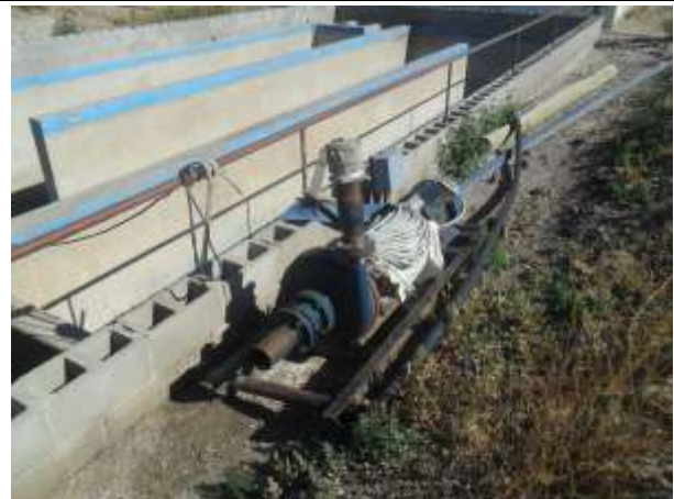
Foto 10 - Bomba desactivada cercana a cámara de cloración
