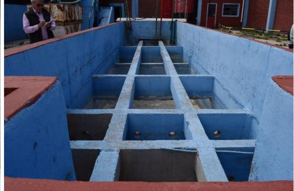
**Foto 6.** Equipo decantador/flotador de sólidos que pudieran estar presentes en el líquido de sangre proveniente de la fosa de recepción de materia prima
