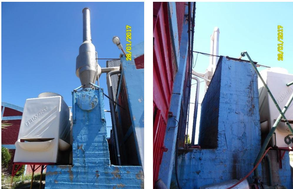
**Fotos 23 y 24.** *Vistas del equipo de tratamiento de vahos del equipo evaporador*
