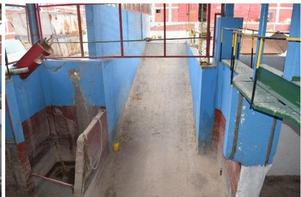
**Foto 4.** Vista de la rampa de acceso de equipos de carga en el sinfín N° 1 situado en el interior de la fosa de recepción de materia prima
