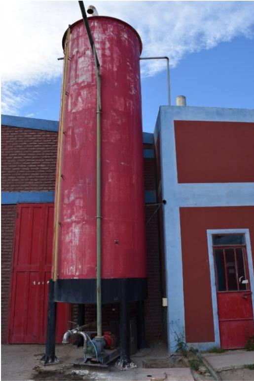
**Foto 11.** Vista del tanque de acopio de aceites recuperados por la etapa de centrifugación y separación de sólidos, ambos contenidos en los líquidos de cola y de prensa
