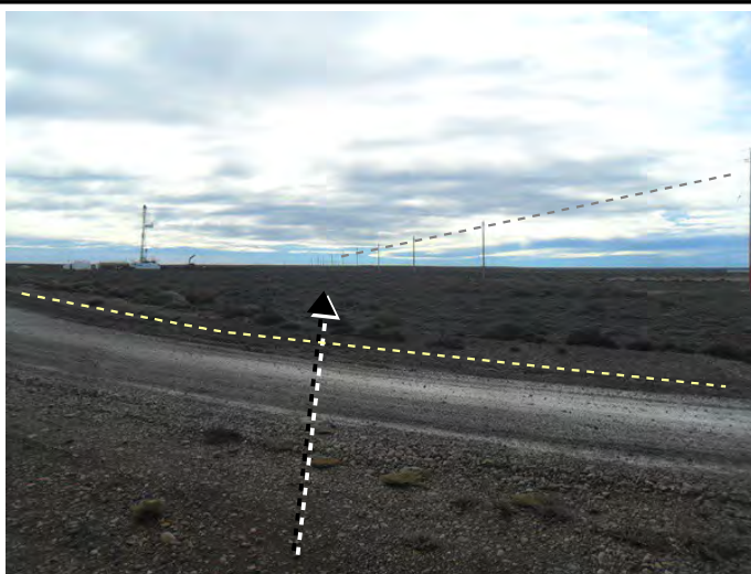
Foto 22 Línea eléctrica cruza camino de acceso general a pozos.(línea punteada amarilla). Fotografía en dirección NE.
