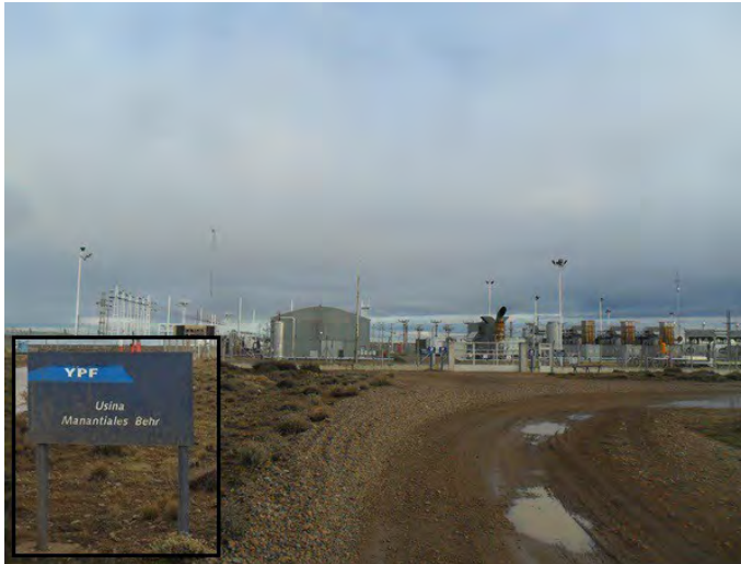
Foto 10 Cartel de identificación Usina MB Vista general Fotografía en dirección NO.
