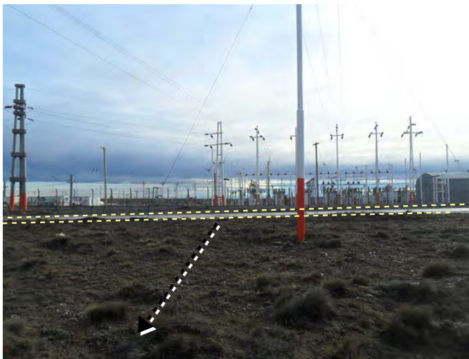
Foto 11 Inicio del tendido eléctrico 35kv en Usina, cruza camino principal (línea punteada amarilla) en dirección S. Fotografía en dirección N.
