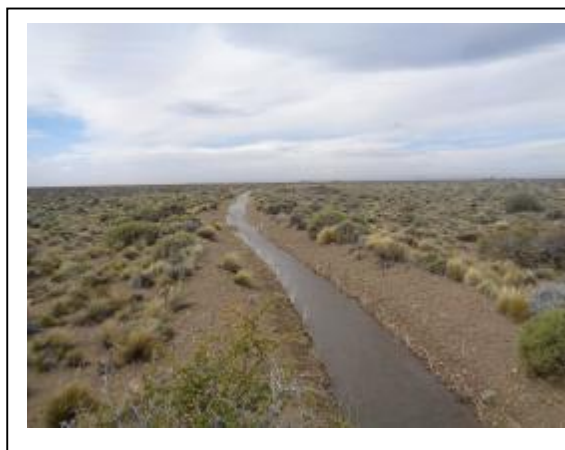
Canal de riego (S44° 57'08,5" O 70° 23'17,5")
