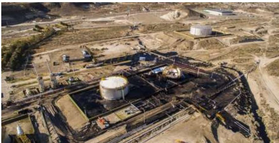
Figura 17: Tanques de almacenamiento de hidrocarburos. Derrame de fondos de tanque objeto del tratamiento propuesto.
