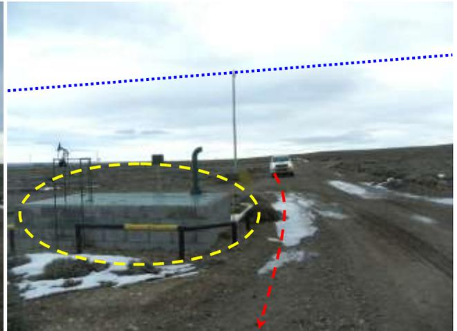
**Foto III.A-14.** Futuro emplazamiento del gasoducto por margen interno de camino. Se observan interferencias con línea eléctrica (azul) y cámara de inspección (amarillo). Fotografía en dirección SO ( $45^{\circ} 56' 8,26''$  S -  $68^{\circ} 44' 8,68''$  O).
