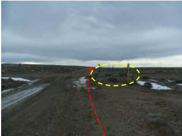
**Foto III.A-13.** Futuro emplazamiento del gasoducto por margen interno de camino. Interferencia con cámara de inspección (amarillo). Fotografía en dirección NE ( $45^{\circ} 56' 9,89''$  S -  $68^{\circ} 44' 9,76''$  O).
