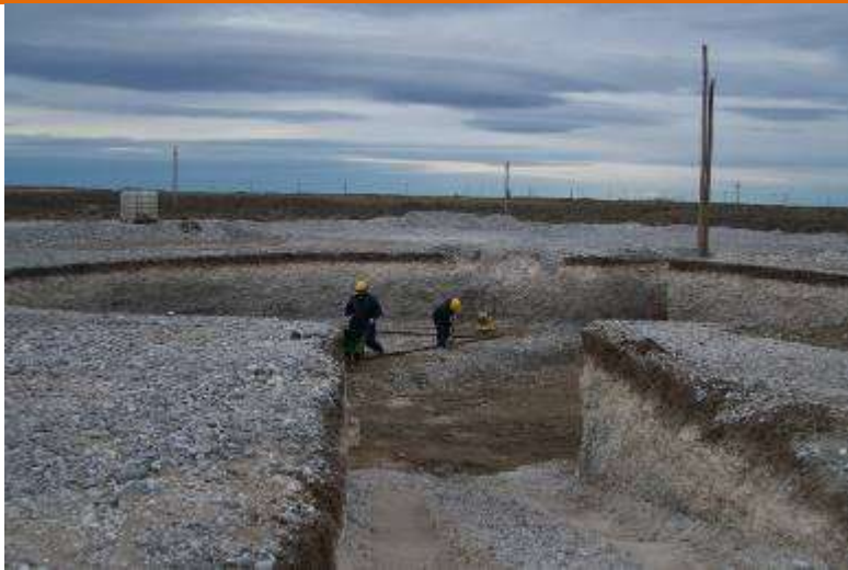
Foto 26: Construcción de fundación.
