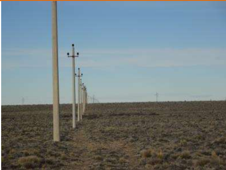
Foto 18: Poste de tendido eléctrico aéreo desafectado en las inmediaciones donde se ubicará el Aerogenerador 13.
