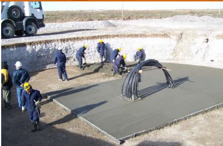
Foto 27: Construcción de fundación.
