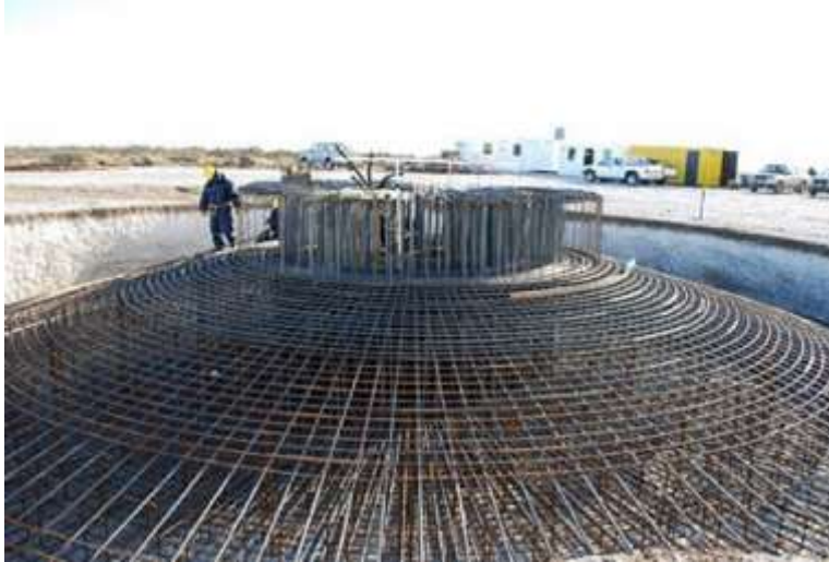
Foto 28: Construcción de fundación.
