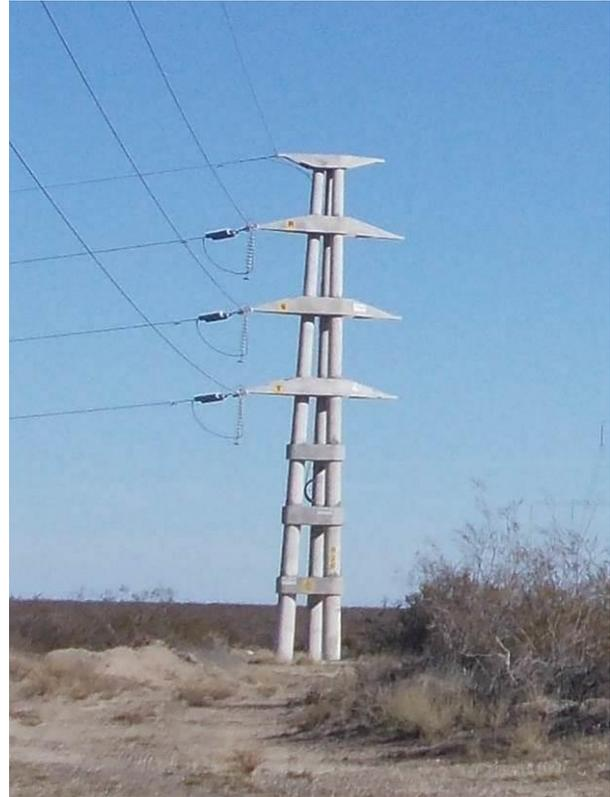
**Figura 2.** Esquema estructura de apoyo de LAT proyectada y vista de la instalada de iguales características en el área de influencia (LAT del PE LB IV).
