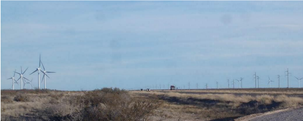
Figura 112. Vista Parque Eólico Loma Blanca IV sobre Ruta Nacional 3.
