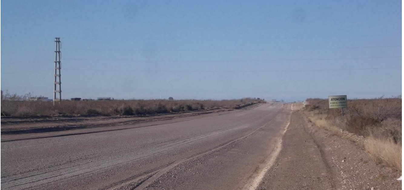
Figura 108. Vista Ruta Provincial 4 en cercanías al cruce de la Alternativa 3 de LAT bajo estudio.
