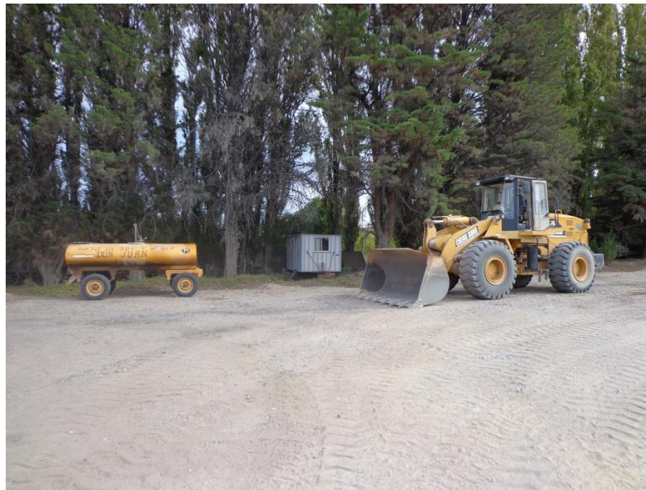
CASILLA, PALA CARGADORA FRONTAL Y CHULENGO DE COMBUSTIBLE
