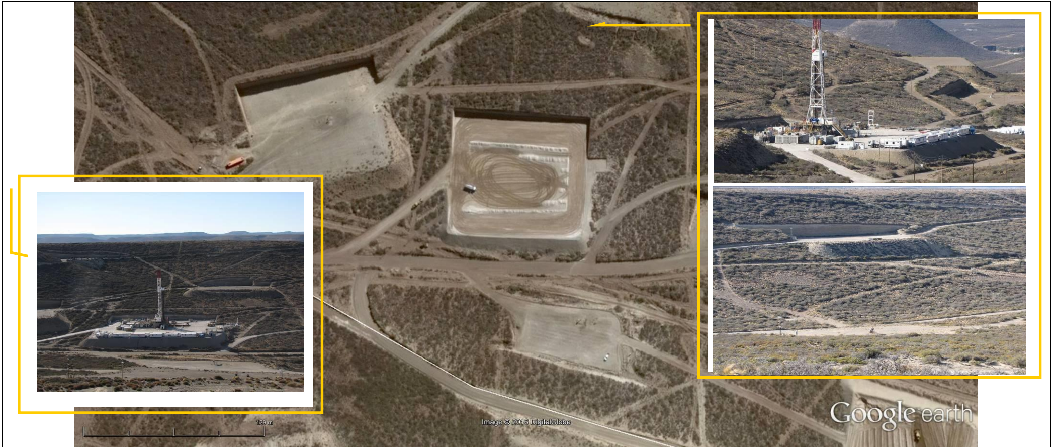
Perforaciones, instalaciones petroleras
