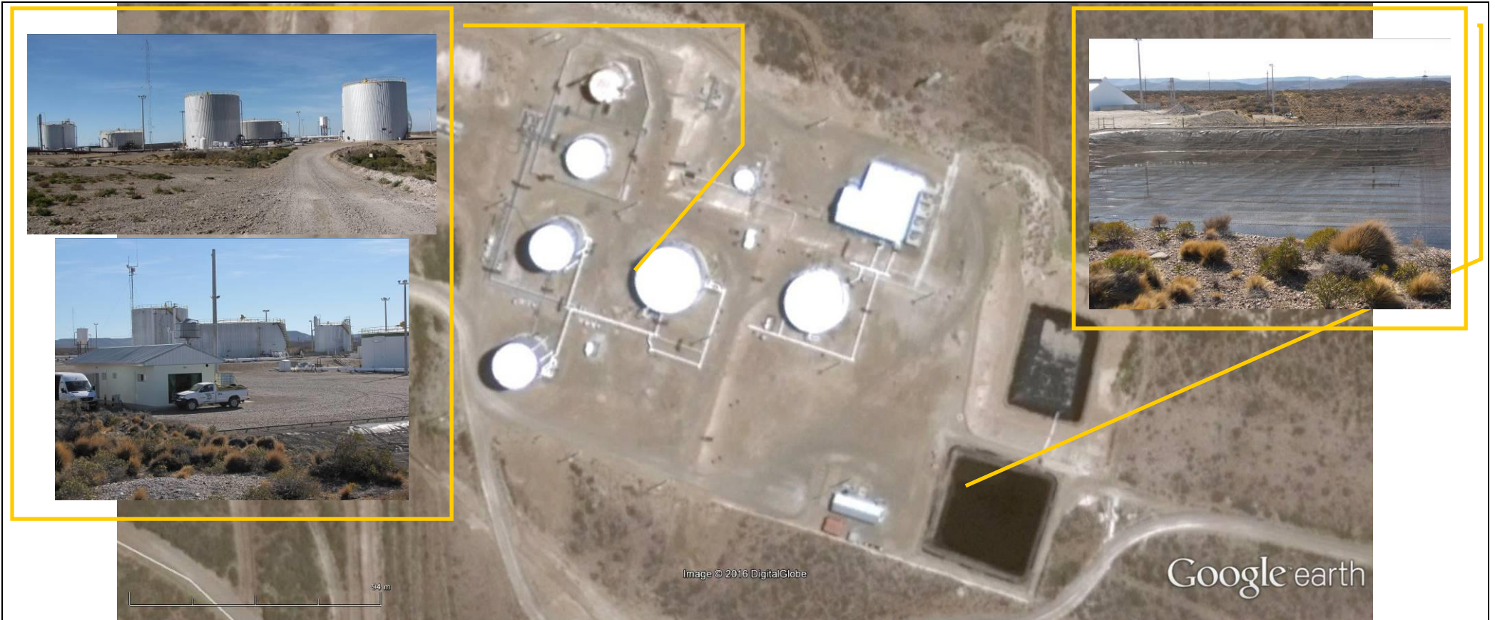
Planta de Agua – Pileta – Oficinas de Operación PEDI
