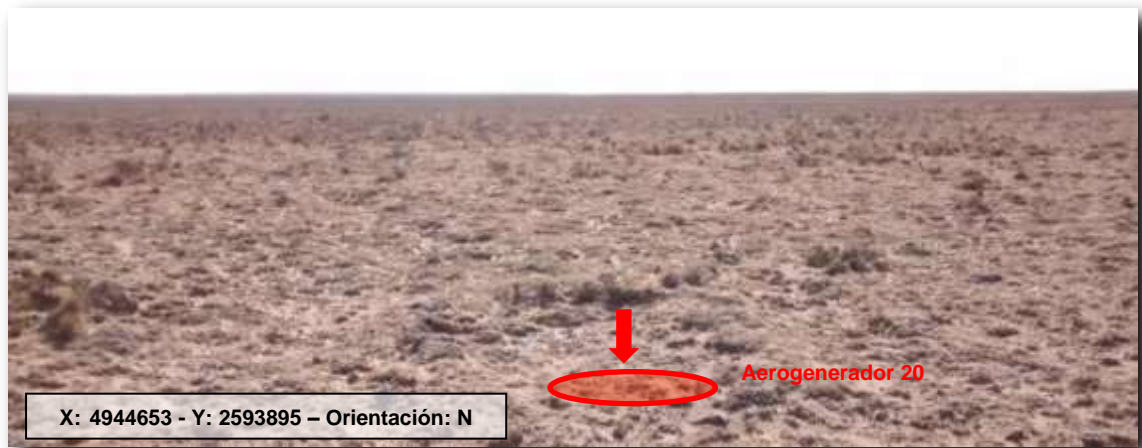
Foto N° 26: Ubicación del Aerogenerador 20.
