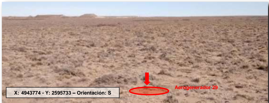
Foto N° 35: Ubicación del Aerogenerador 29.
