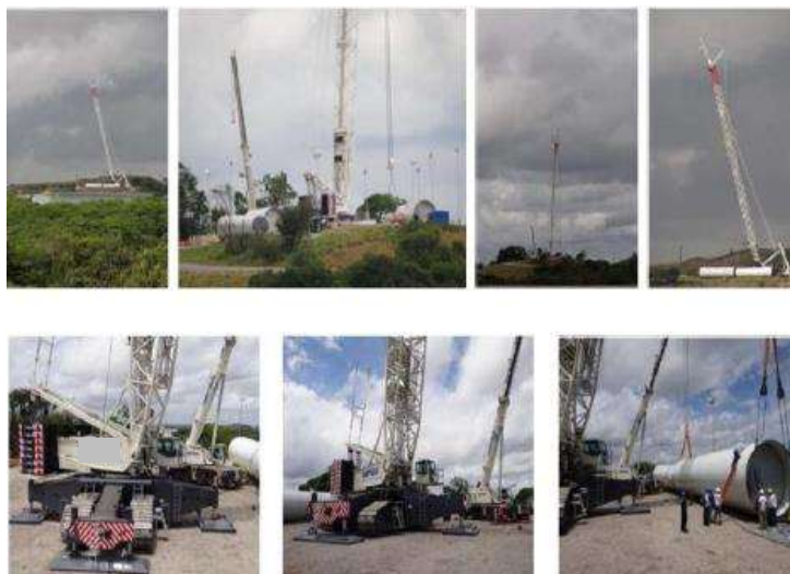
Figura Nº 15: Equipamiento utilizado en el montaje de equipos.
