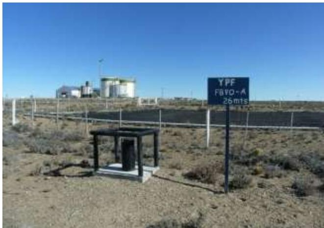
**Foto IV.1-7.** Freatímetro FBVO-A. Fuera del predio de la Batería Voster.
