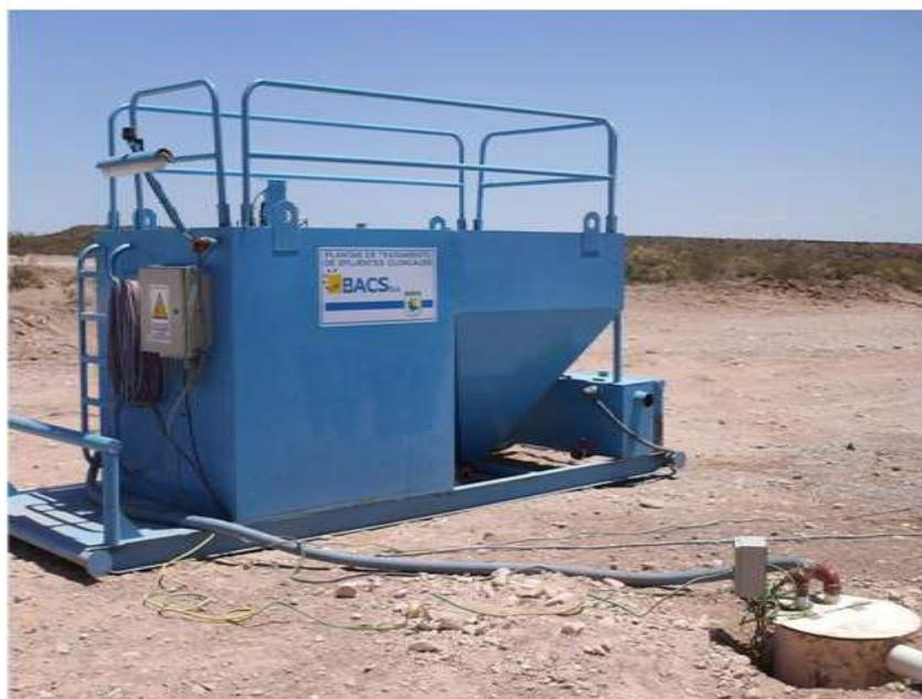
Foto III.B-77. Vista de una Planta de Tratamiento compacta.
