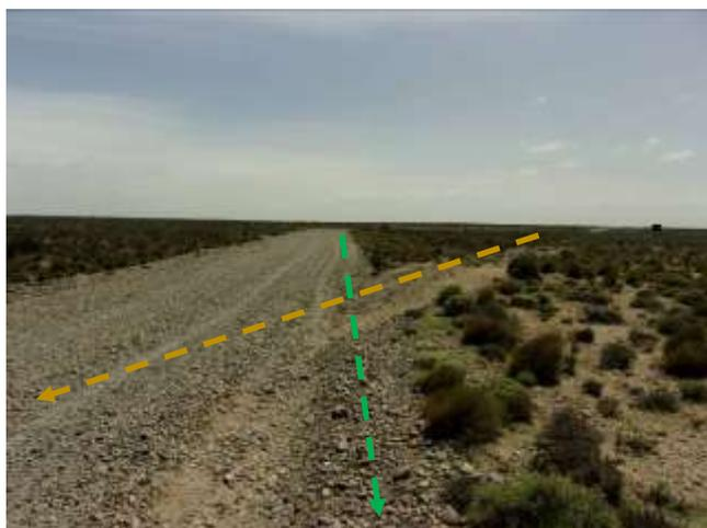
**Foto III.B-5.** Emplazamiento de acueducto por margen interno de camino (Verde) e interferencia con picada existente (Marrón). Foto en dirección N.
