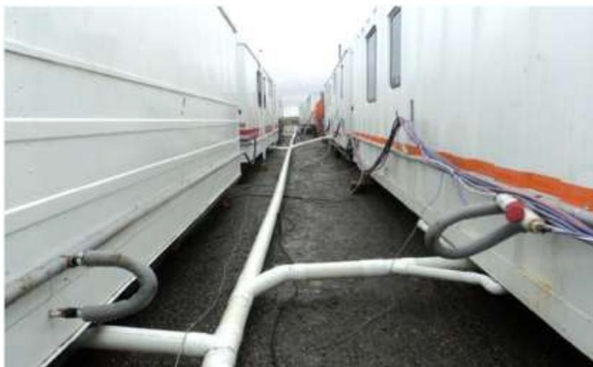
Foto III.B-76. Conexiones colectoras de efluentes crudos.
