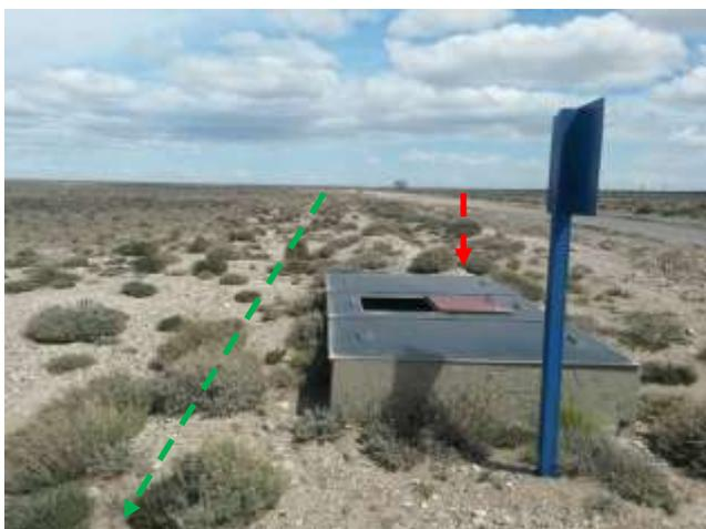
**Foto III.B-19.** Emplazamiento de acueducto por picada existente (verde). Válvula de bloqueo N° 3 (rojo). Foto en dirección SO.
