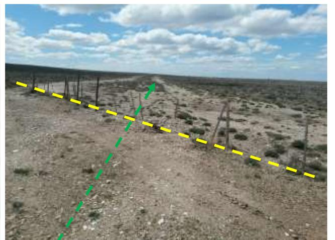
**Foto III.B-20.** Emplazamiento de acueducto por picada existente (verde). Interfiere alambrado rural (amarillo).
