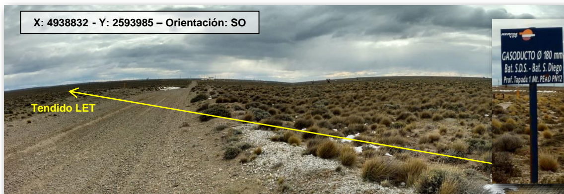
Foto N° 15: Cruce gasoducto Bat. SDS - Bat. S.Diego.
