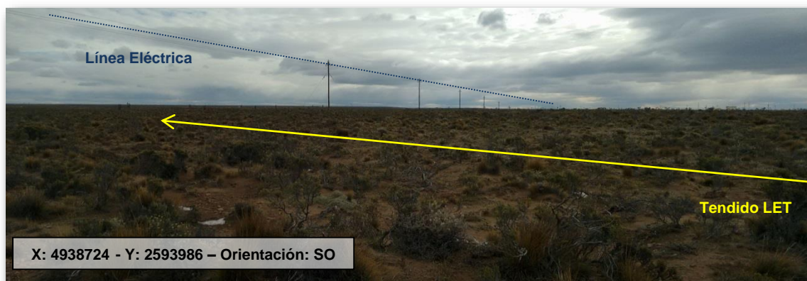
Foto N° 16: Cruce tendido de línea eléctrica en baja tensión.
