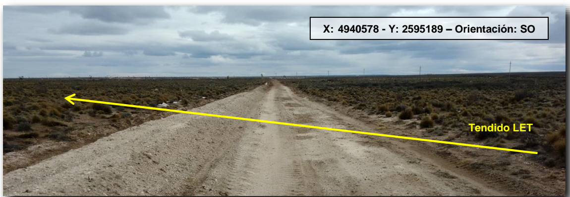
Foto N° 9: Cruce de picada.
