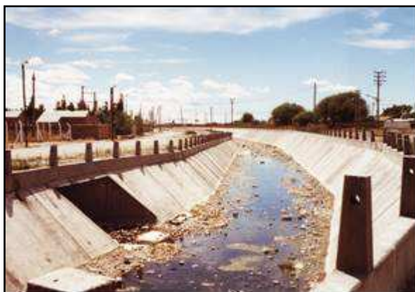
Foto 2: Canal de Drenaje Pluvial “Ovoide”
