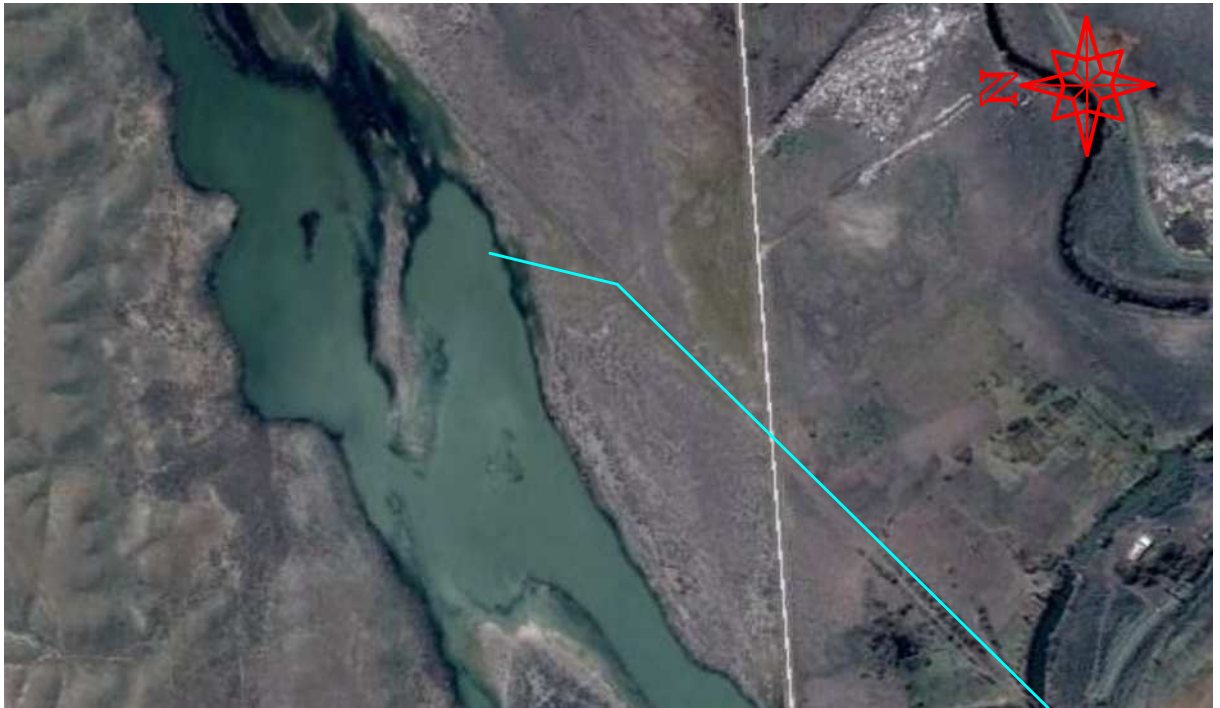
DETALLE INGRESO IMPULSIÓN A LAGUNA II COORDENADAS: 43°14'23,56" lat.sur; 65°15'15,80" long. oeste
