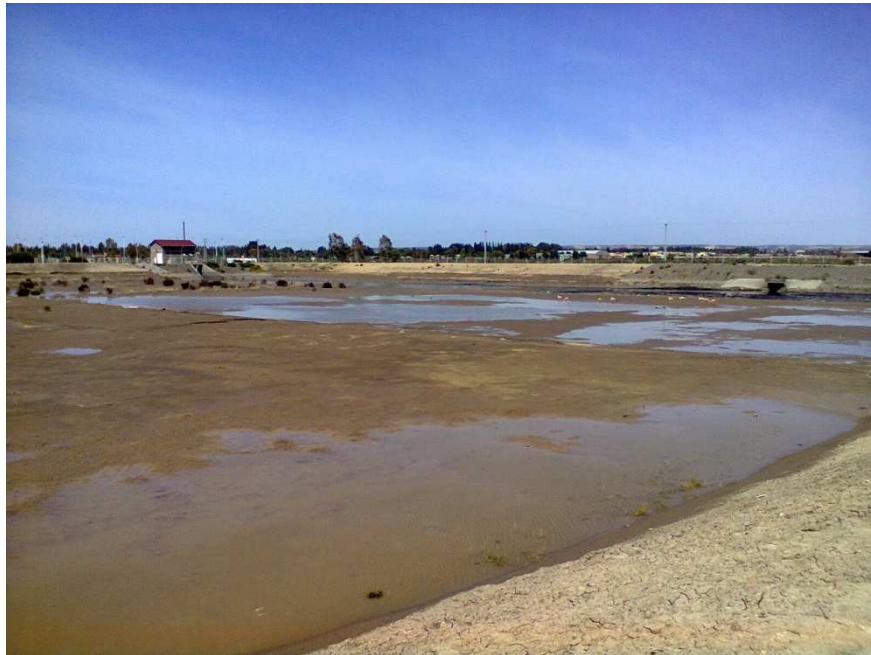
Fotografía N° 13: Cuenco Owen - Vista del cuenco en donde se observa los tres niveles de fondo o bermas
