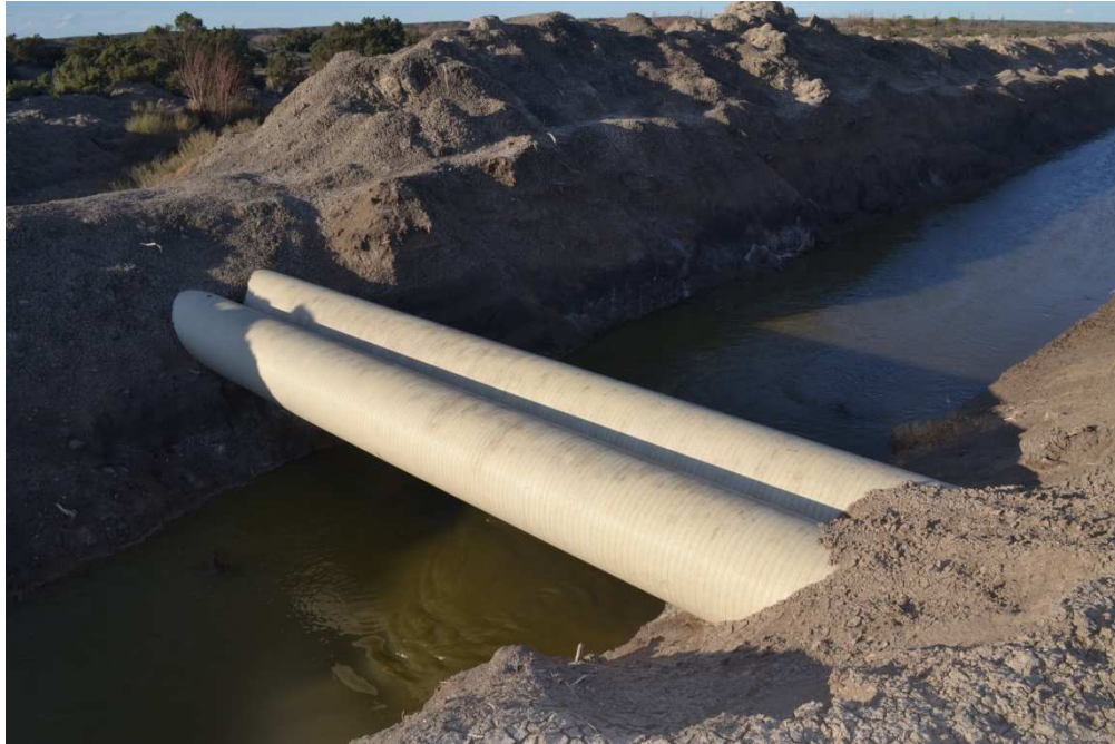
Fotografía N° 31: Sistema Lagunar - Cruce del canal de riego “C. Williams” con canal de Vinculación Laguna IV-VI que en la presente obra se reconstruirá
