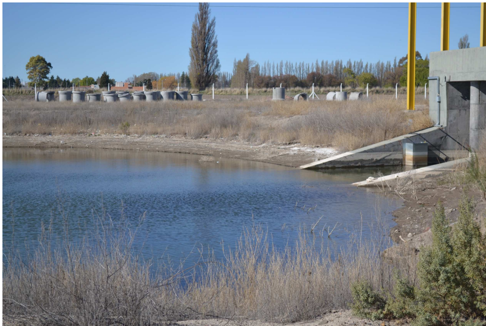
Fotografía N° 7: Cuenco Musters – Ingreso al sector de bombeo – Situación actual: oct. 2015
