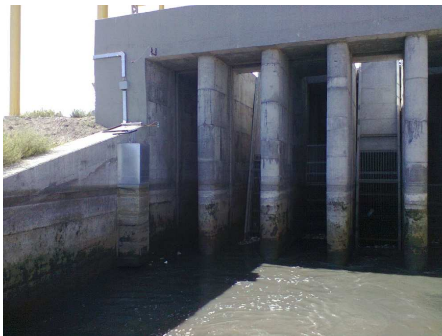
Fotografía N° 8: Cuenco Musters – Ingreso al sector de bombeo y Rejas
