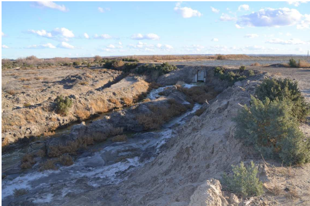
Fotografía N° 30: Sistema Lagunar - Comienzo del Canal existente de vinculación entre Lagunas IV y VI, que con la presente obra se reconstruirá y modificará su traza en el primer tramo
