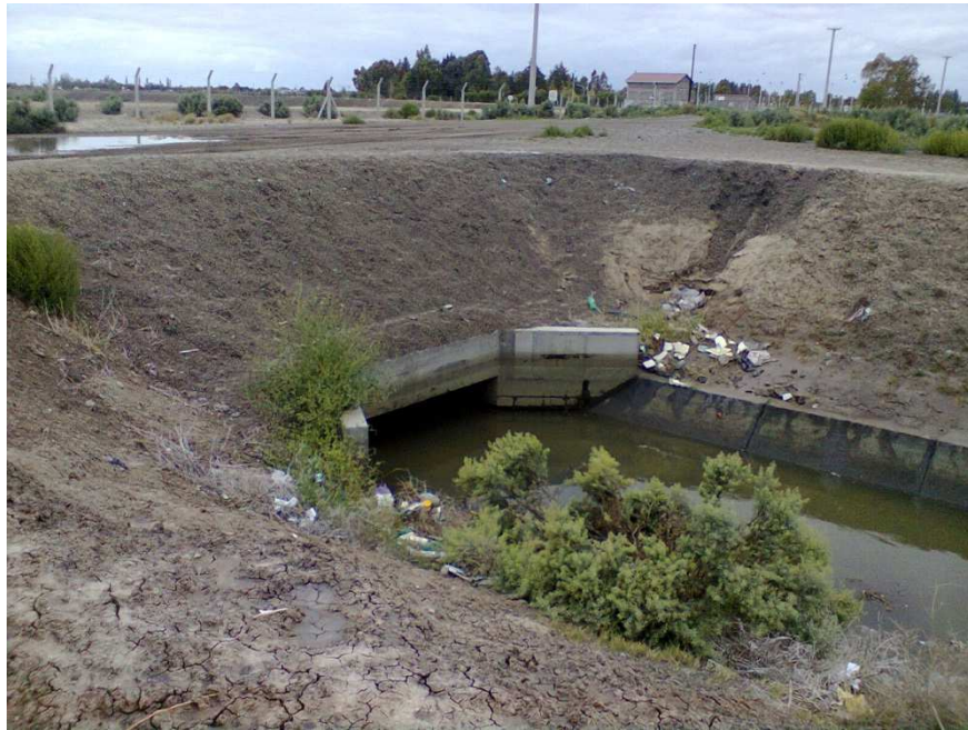
Fotografía N° 9: Cuenco Musters – Conducto pluvial de ingreso
