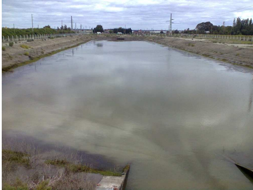
Fotografía N° 1: Cuenco Musters - Nivel 2,56 m
