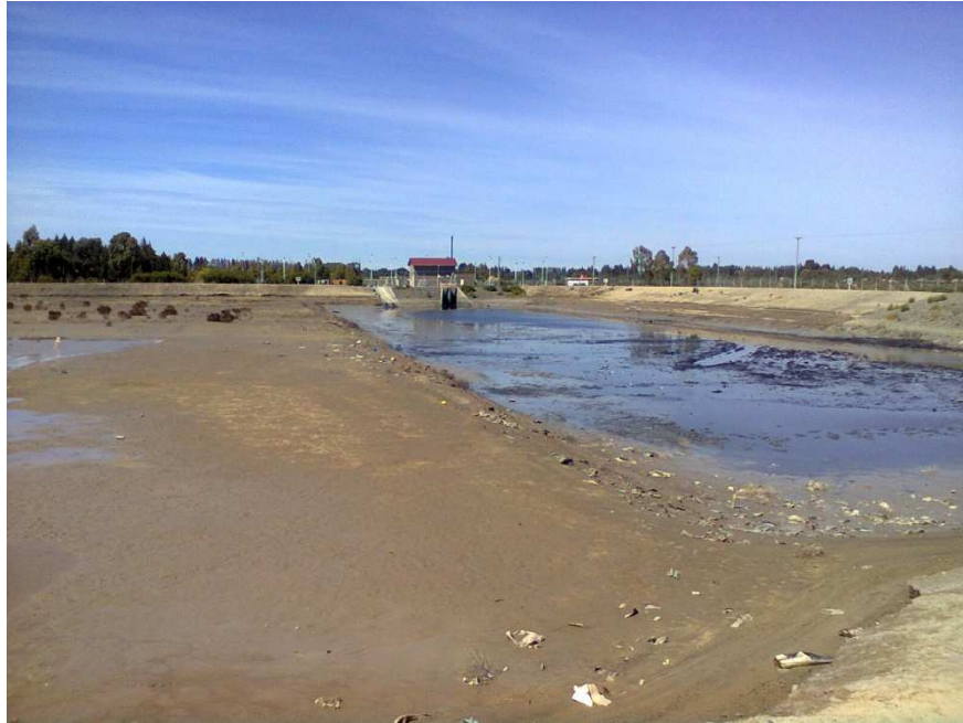
Fotografía N° 11: Cuenco Owen - Subcuencos 1 y 2 e Ingreso a la Estación de Bombeo
