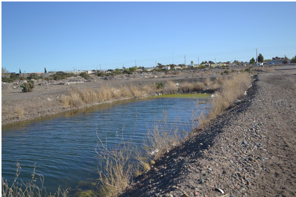
Fotografía N° 10: Canal de llegada a Cuenco Owen – Situación actual: octubre 2015
