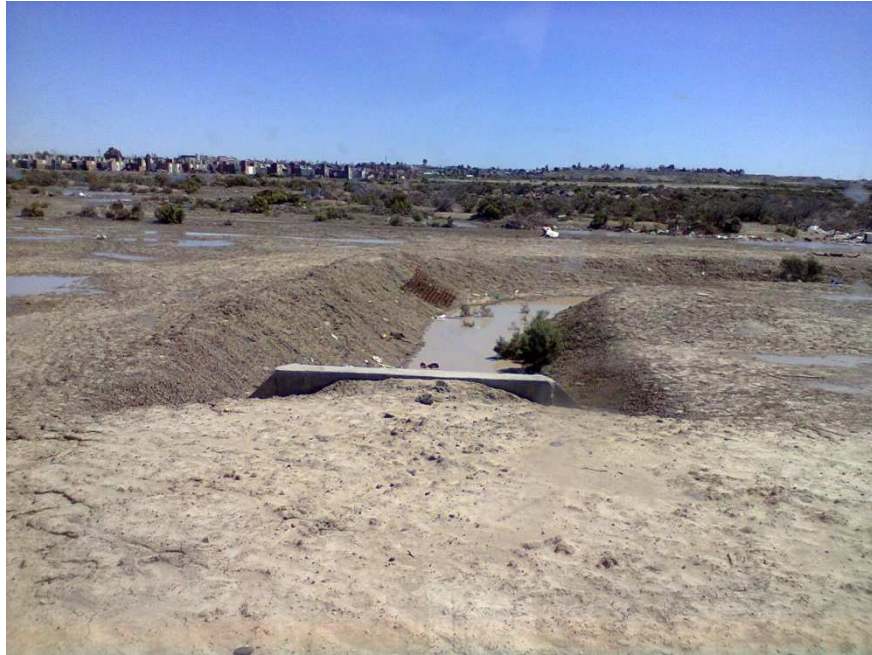
Fotografía N° 15: Cuenco Owen - Vista del canal de Descarga
