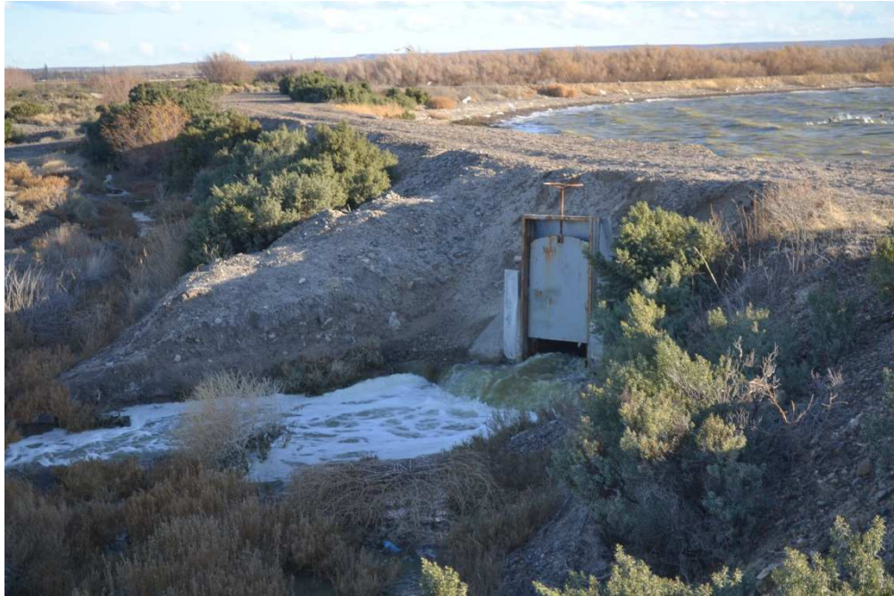
Fotografía N° 29: Sistema Lagunar - Compuerta existente en Laguna IV en Canal de Vinculación con Laguna VI
