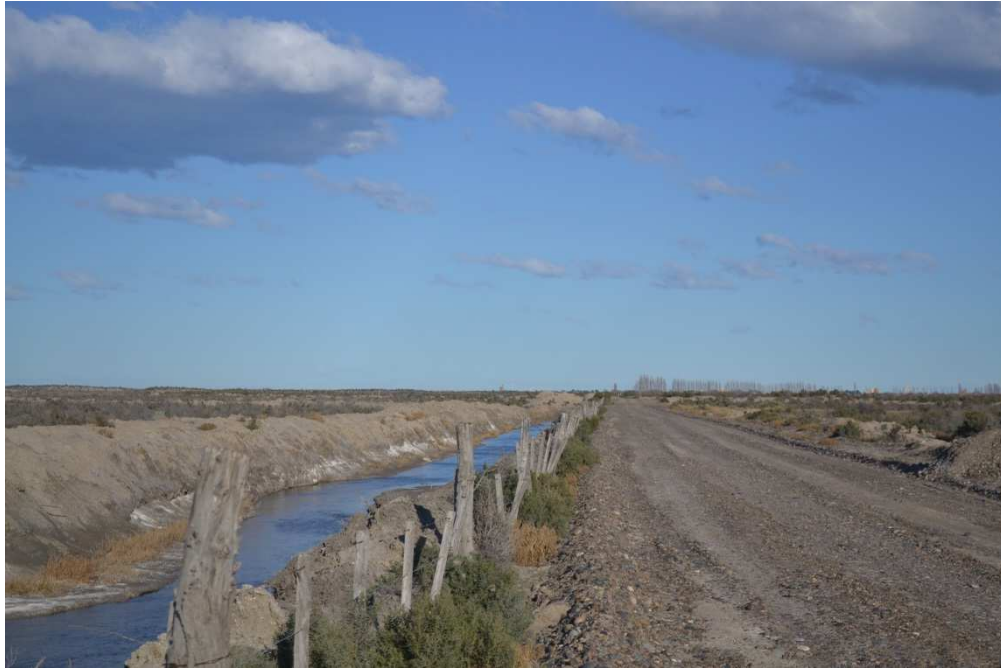
Fotografía N° 33: Sistema Lagunar - Otra Vista del Canal de Vinculación entre Lagunas IV y VI en Progresiva 1300,00
