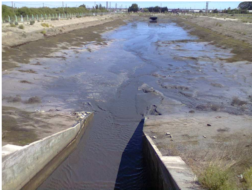
Fotografía N° 4: Cuenco Musters – Nivel 1,00 m
