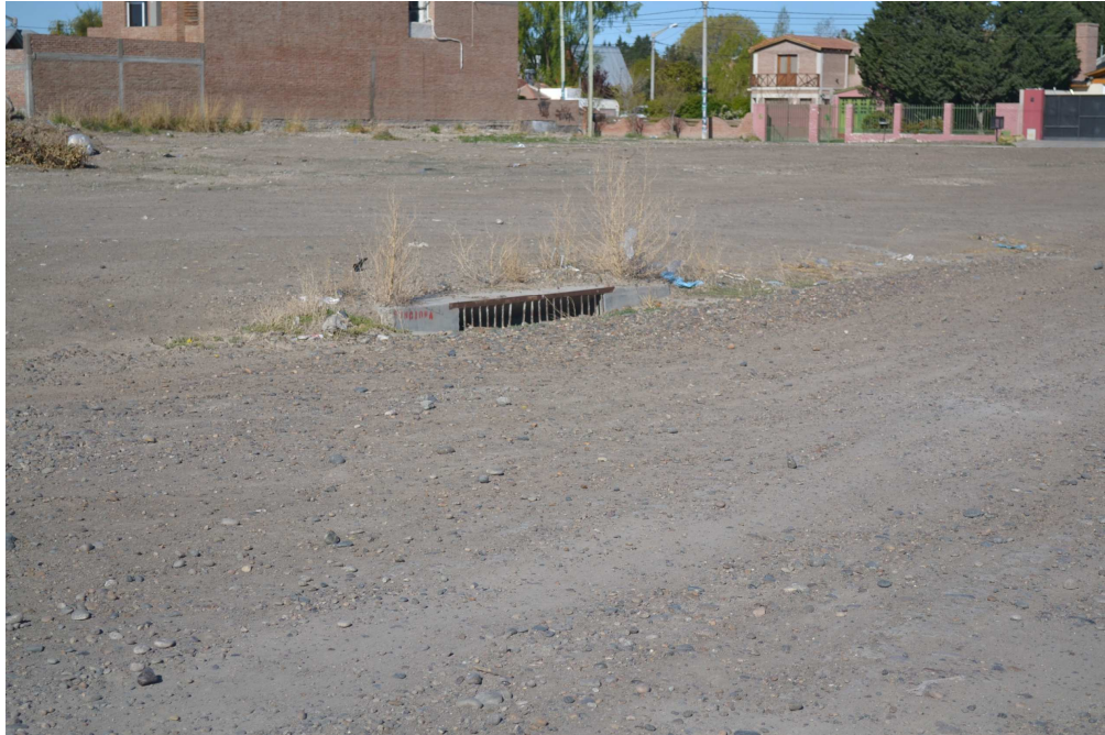
Fotografía N° 19: Traza prevista - Sumidero donde comienza Conducto existente (Mermoz y J. M. de Rosas)
