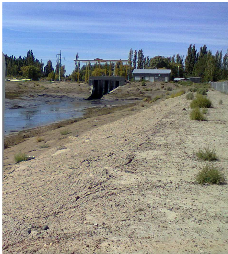
Fotografía N° 6: Cuenco Musters – Ingreso al sector de bombeo
