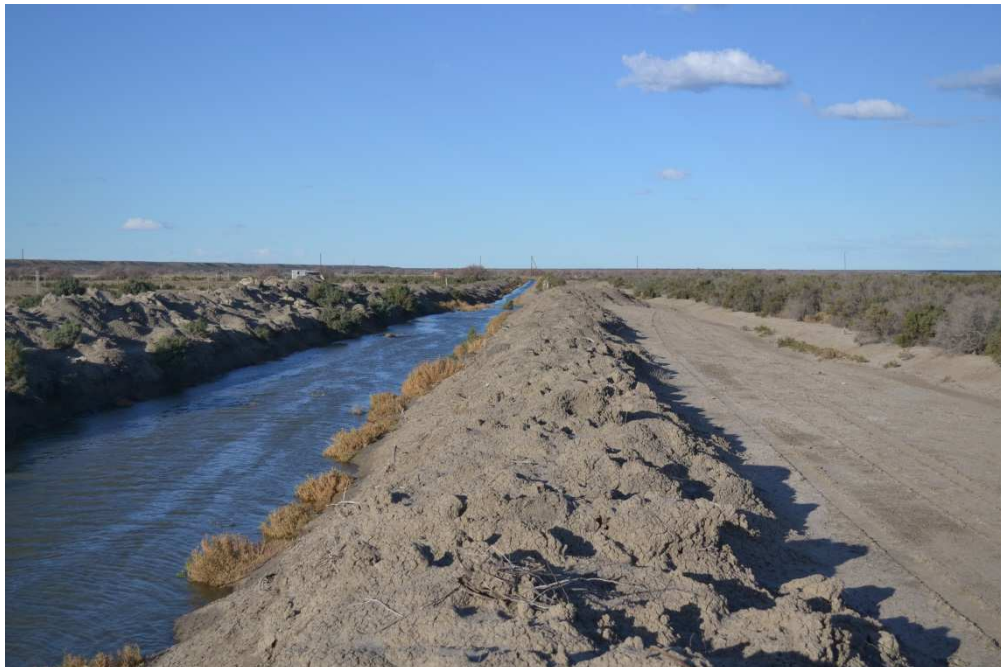
Fotografía N° 32: Sistema Lagunar - Vista del Canal de Vinculación entre Lagunas IV y VI - Progresiva 500,00
