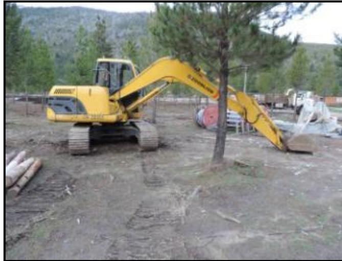
Foto N° 9. Máquina excavadora con oruga
