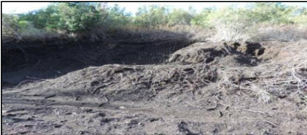
Foto N° 8. Sector 2° de 100 m 2 a remediar
