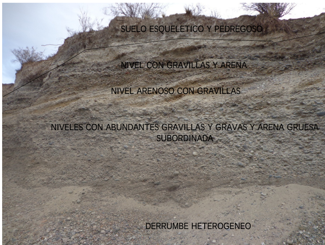
Fotografía N° 1: Perfil litológico del frente de la cava existente.
