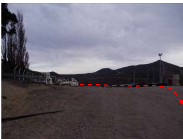
Foto III.B-46. Emplazamiento del oleoducto por margen interno de camino, a la izquierda se encuentran instalaciones de YPF. Foto en dirección Oeste.
