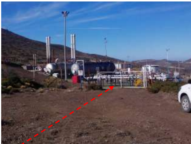
Foto III.B-35. Fin del futuro emplazamiento del oleoducto en el colector de la Planta Deshidratadora Manantiales Behr. Foto en dirección Sur.
