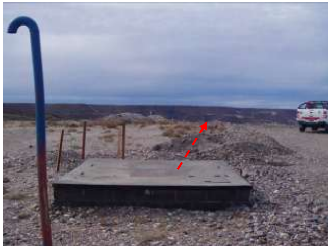
Foto III.B-38. Inicio del tramo del oleoducto en la cámara AM 421. Foto en dirección Este.
