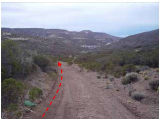
Foto III.B-40. Emplazamiento del oleoducto por picada. Foto en dirección Este.
