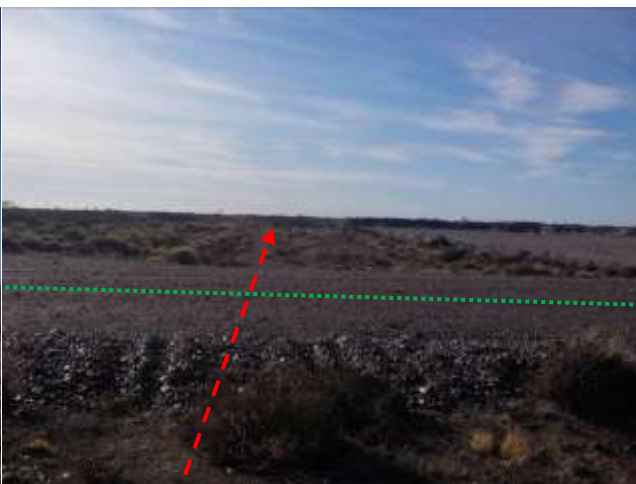
Foto III.B-16. Futuro emplazamiento del oleoducto por picada, interferencia con camino de acceso al pozo Mxs 654. Foto en dirección Este.
