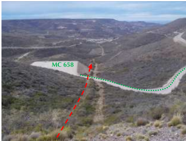
Foto III.B-39. Emplazamiento del oleoducto por picada sobre curso efímero, interferencia con camino de acceso (verde) al pozo MC 658. Foto en dirección Este.
