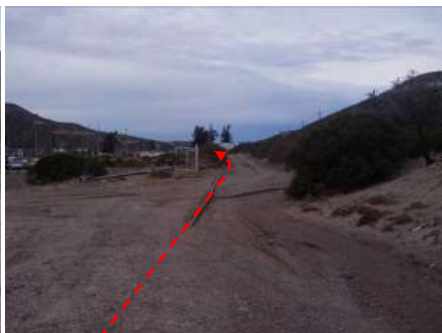
Foto III.B-45. Emplazamiento del oleoducto por picada, a la izquierda se observan instalaciones de YPF, interferencia con camino de acceso. Foto en dirección Este.
