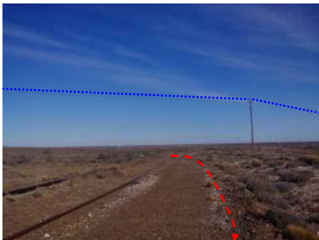
Foto III.B-15. Futuro emplazamiento del oleoducto por picada, interferencia con línea eléctrica (azul). Foto en dirección Oeste.
