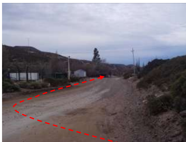
Foto III.B-47. Emplazamiento del oleoducto por margen interno de camino, a la izquierda se encuentra la empresa Weatherford. Foto en dirección Este.
