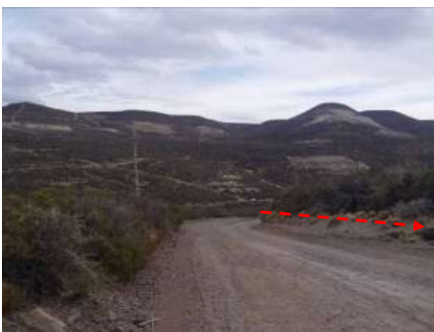
Foto III.B-55. Oleoducto por margen interno de camino, interferencia con línea eléctrica. Foto en dirección SO.
