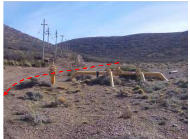
Foto III.B-34. Futuro emplazamiento del oleoducto por pica, Interferencia con válvulas de gas y camino. Foto en dirección Norte.
