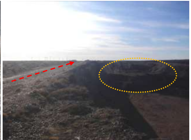
Foto III.B-12. Emplazamiento del oleoducto por picada. Hacia la derecha de la picada se encuentra una cantera (naranja). Foto en dirección Norte.
