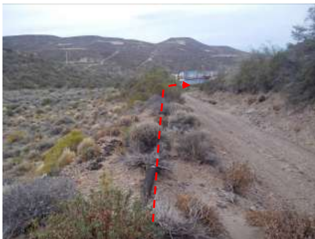
Foto III.B-43. Emplazamiento del oleoducto por borde de picada, muy revegetado. Foto en dirección Este.
