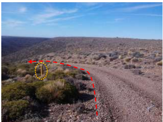
Foto III.B-31. Futuro emplazamiento del oleoducto por picada sobre valle, se observa protección catódica. Foto en dirección Sur.
