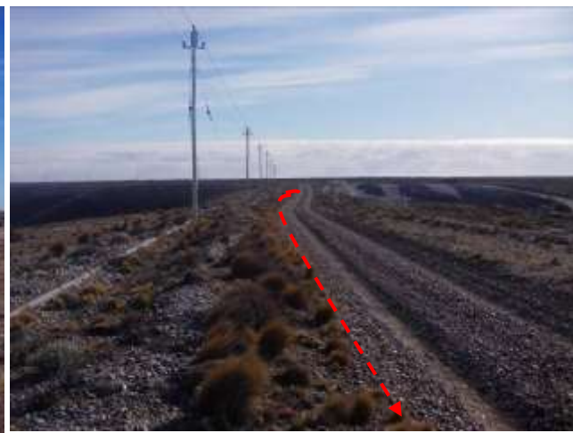
Foto III.B-24. Futuro emplazamiento del oleoducto por picada. Foto en dirección Norte.
