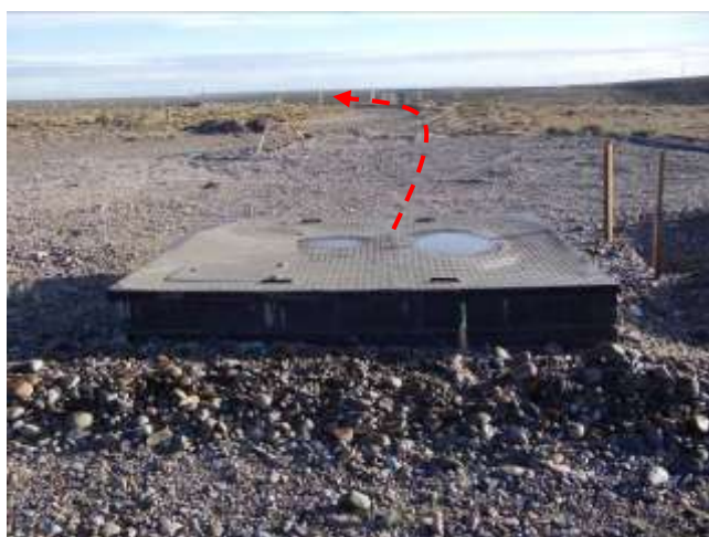
Foto III.B-1. Inicio del futuro tramo del oleoducto en la cámara AM 421. Foto en dirección Norte.
