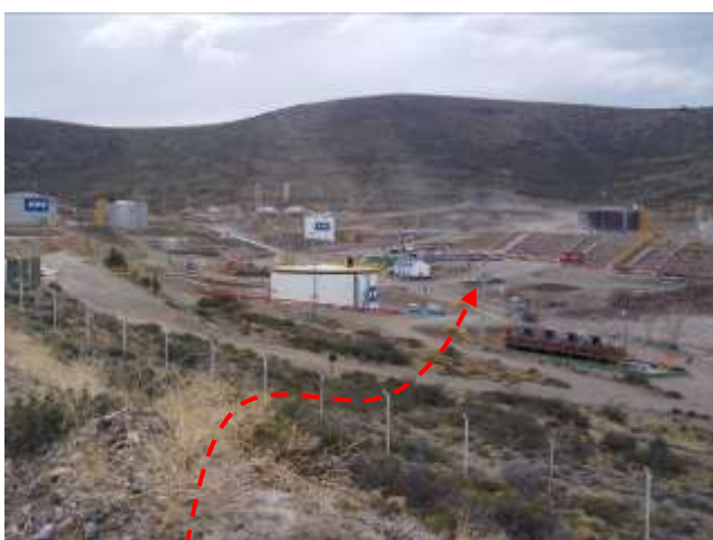
Foto III.B-60. Oleoducto por locación de la Planta Deshidratadora MB, interferencia con el cerco perimetral de la planta. Foto en dirección Norte.
