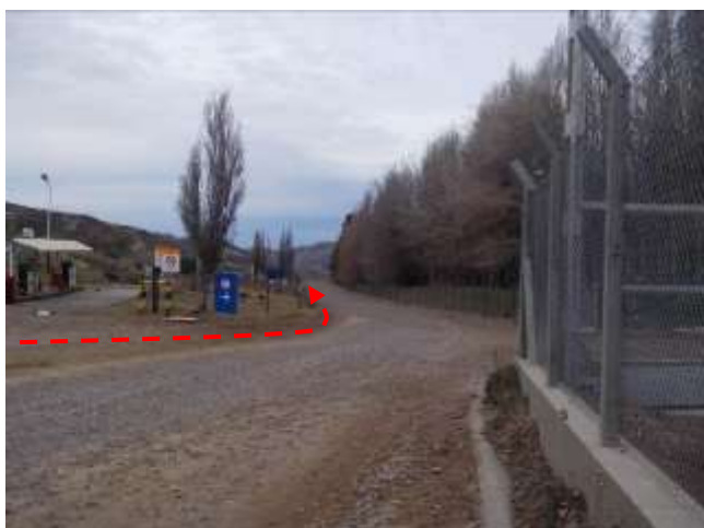
Foto III.B-50. Emplazamiento del oleoducto por margen interno de camino, a la derecha se encuentra el Módulo MB y Activos Manantiales Behr Norte y Sur, a la izquierda instalaciones de YPF. Foto en dirección Este.
