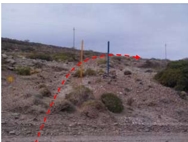
Foto III.B-58. Oleoducto por picada, interferencia con camino y con línea eléctrica. Foto en dirección Norte.
