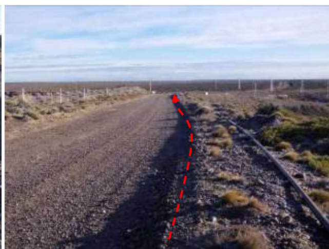
Foto III.B-2. Futuro emplazamiento del oleoducto por margen interno de camino. Foto en dirección NO.
