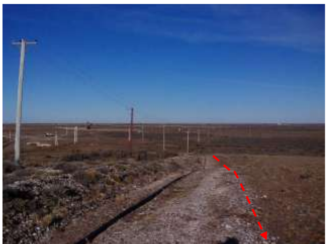
Foto III.B-5. Futuro emplazamiento del oleoducto por picada. Foto en dirección SO.
