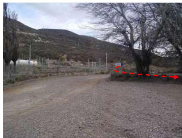
Foto III.B-49. Emplazamiento del oleoducto por margen interno de camino, a la izquierda se encuentra el Módulo MB y a la derecha el estacionamiento. Foto en dirección Oeste.
