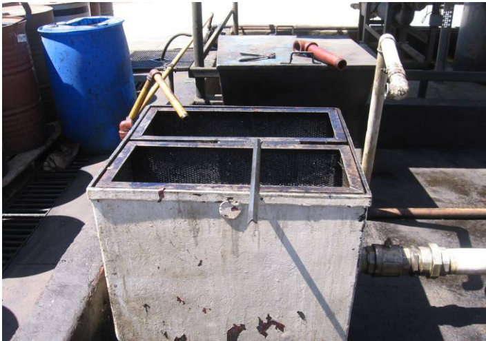
Figura 6: Sala de Filtrado, base Comodoro Rivadavia.
