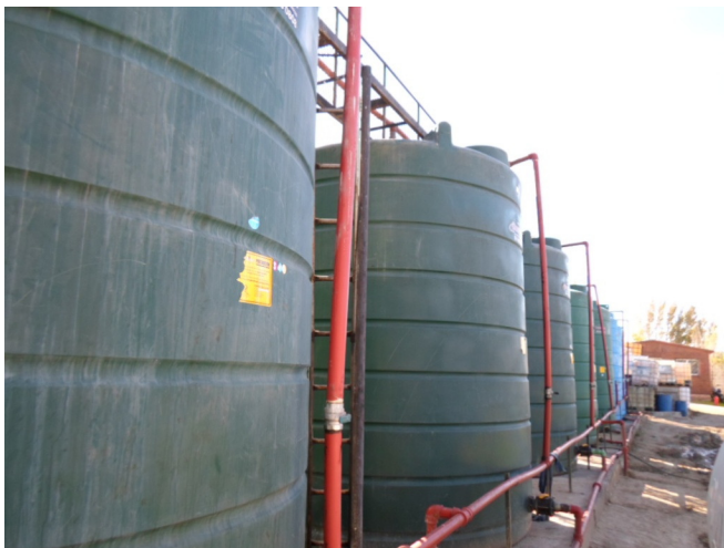
Figura 10: Planta de Tratamiento Físico Químico (PTFQ)
