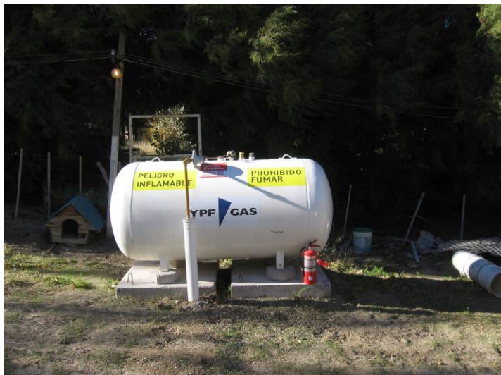
Figura 3: Instalación de gas, cuyo proveedor es YPF-Gas. Se encuentra dentro del predio y cuenta con matafuegos ABC.
