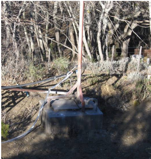
Figura 4: Acueducto operado por la SCPL (derecha) y toma de agua que existente que abastece al predio (arriba).
