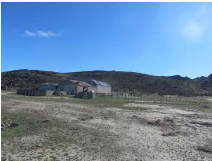
Imagen 18. Vivienda rural abandonada
