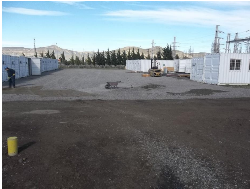
Figura 3.2.2 – Sector del predio de la CTP donde se instalará el nuevo TG.
