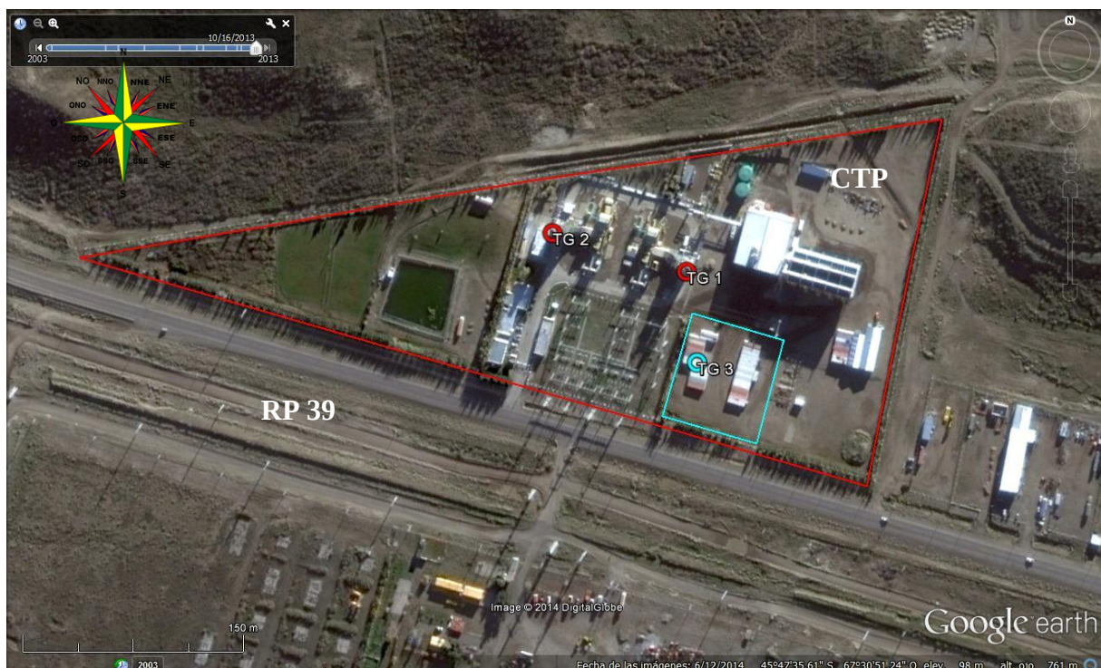
Figura 3.2.1 – Imagen satelital de la CTP. En línea celeste se muestra el sector del predio a ser ocupado por el nuevo proyecto, y en círculo celeste la posición de la nueva chimenea.
