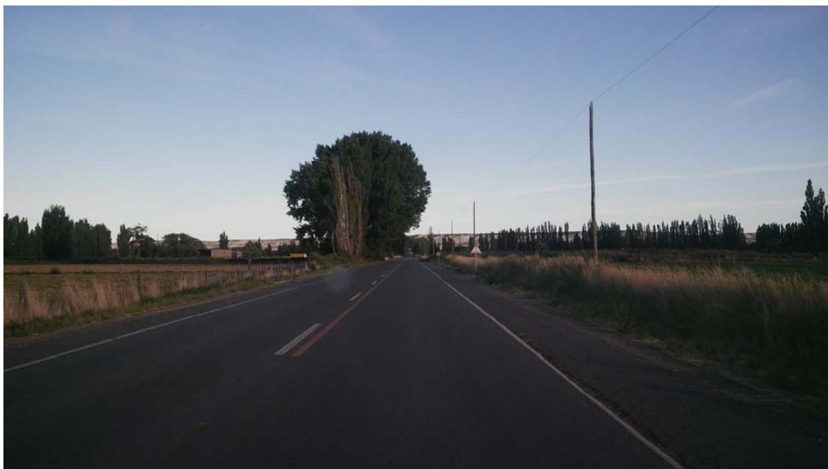
Vía de acceso por Ruta Provincial
