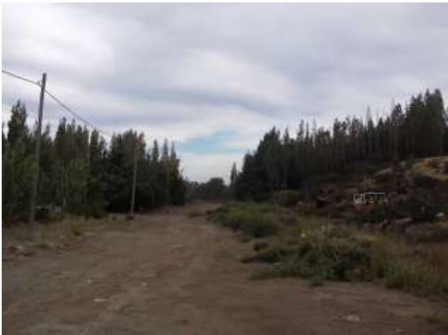
Foto IV.2-53. Esquina 13 hacia el Este. Se observa camino parcialmente revegetado y en mal estado de transitabilidad.
