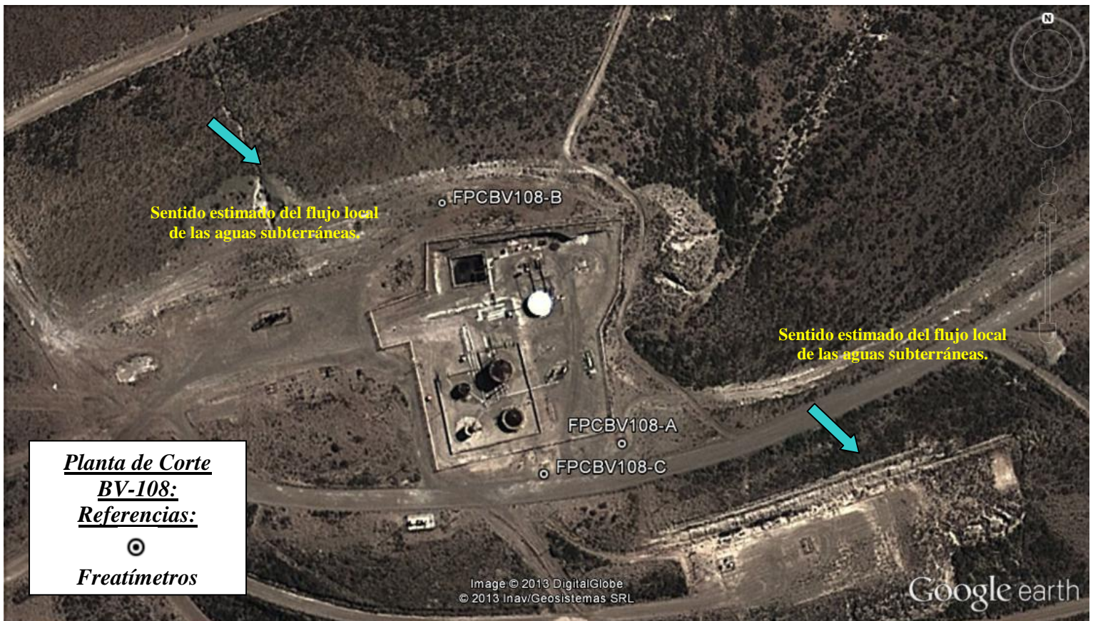
Imagen satelital tomada de Google Earth, donde se observa la posición relativa de los freáticos y el sentido estimado del flujo local de aguas subterráneas para el sector.
