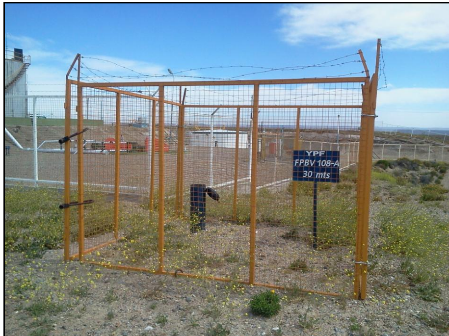
FOTO 3: Freatímetro preexistente FPCBV108-A. Este freatímetro se ubica a 90 metros al sureste de la pileta de emergencias de la planta, fuera del predio de la misma.
