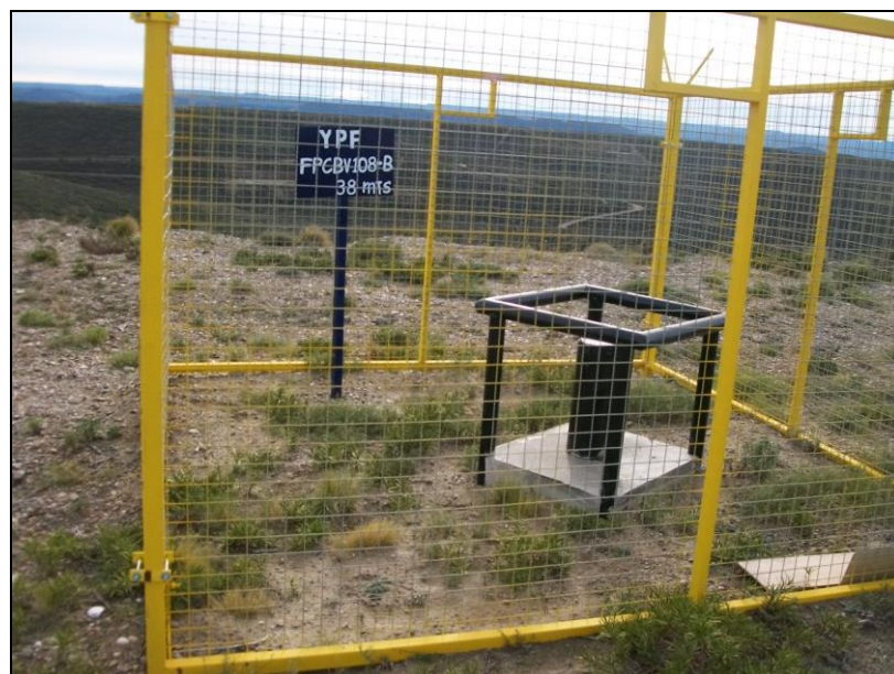
FOTO 2: Freatímetro FPCBV108-B, ubicado a 15 metros al norte del cerco perimetral de la Planta.
