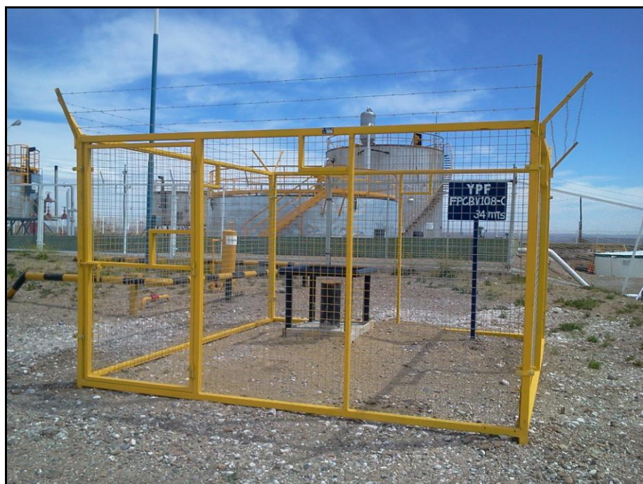
FOTO 2: Freatímetro FPCBV108-C. Ubicado a 24 metros al sureste de la zona de tanques de la Plana, fuera de su predio.
