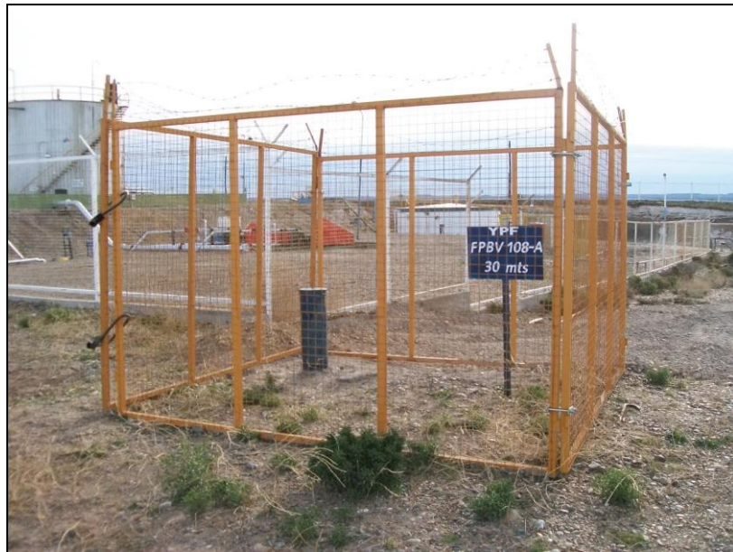
FOTO 1: Freatímetro FPCBV108-A, ubicado a 90 metros al sureste de la pileta de emergencias de la Planta, fuera de su predio. El brocal se encuentra suelto y el dado de cemento partido.
