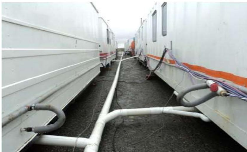
Foto III.B-62. Conexiones colectoras de efluentes crudos.
