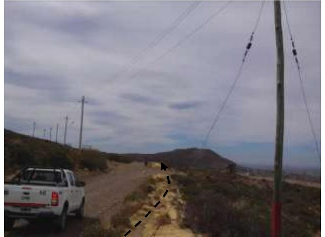
**Foto III.B-28.** Se emplazarán los ductos por margen de camino. Se observa un cruce con línea eléctrica. Foto en dirección Noreste.
