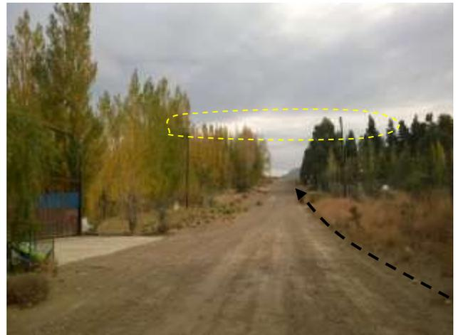
**Foto III.B-6.** Traza los ductos por borde interno de camino interfiriendo con línea eléctrica. Foto mirando al Norte.
