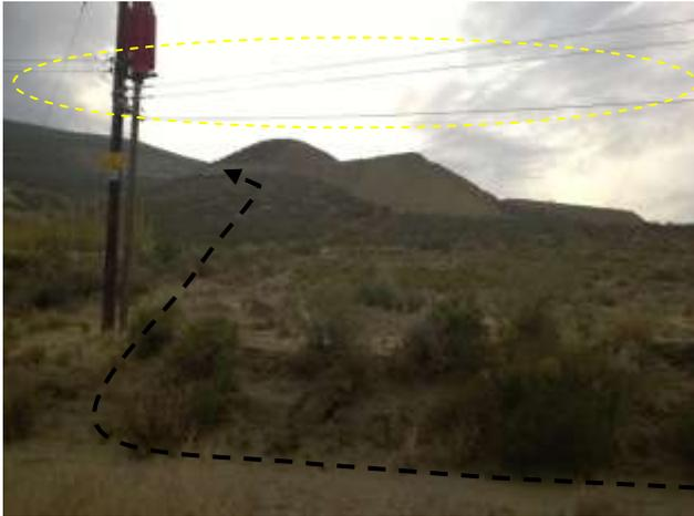
**Foto III.B-21.** Traza de los ductos por margen interno de camino y comienzo traza por terreno virgen interfiriendo con línea eléctrica. Foto en dirección Este.
