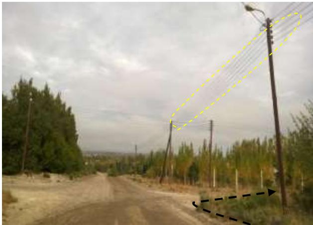
**Foto III.B-5.** Traza los ductos por borde interno de camino interfiriendo con línea eléctrica. Foto hacia al Oeste.
