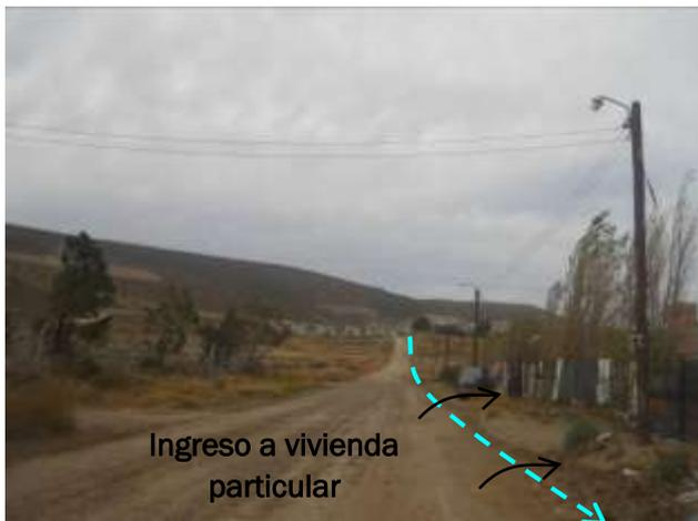
**Foto III.B-53.** Detalle de traza de la LET por borde interno de camino interfiriendo con ingresos a viviendas particulares y con línea eléctrica. Foto mirando al NE.
