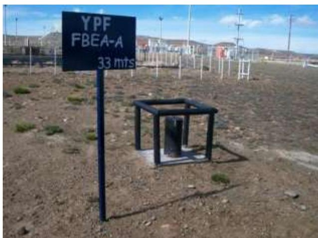
Foto IV.1-15. Freatímetro FBEA-A, ubicado al Oeste de la pileta de emergencias de la Batería EA.
