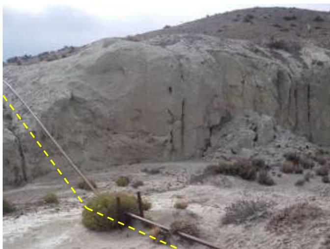
**Foto IV.1-3.** Caída de bloques en cercanías de la traza del ducto. Se observa cañería al Este de la misma (amarillo), ( $45^{\circ}32'28,51''$  S-  $67^{\circ}59'27,14''$  O). Foto en dirección NE.
