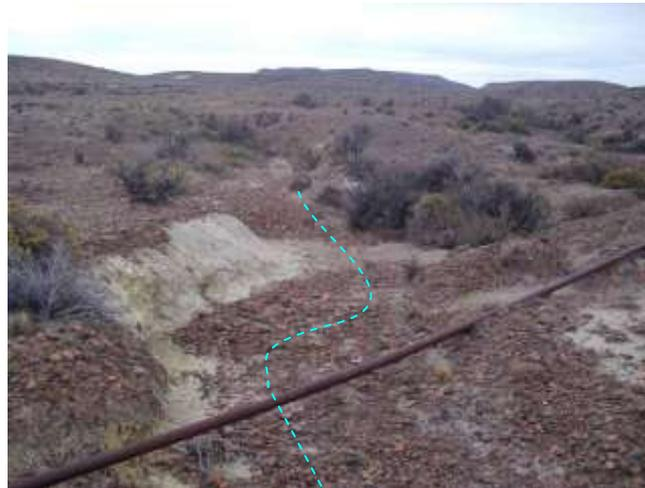
**Foto IV.1-4.** Drenaje efímero interfiriendo con la traza de los ductos (Punto B). Imagen mirando al E.
