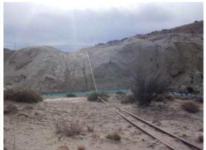
**Foto IV.1-6.** Drenaje efímero profundizado atravesando el ducto (Punto C). Imagen mirando al Norte.
