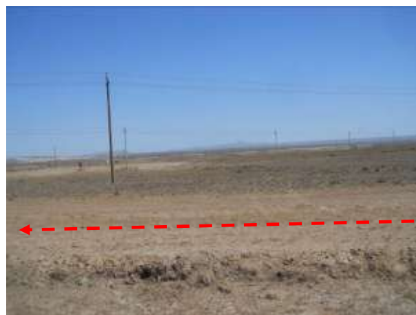
Foto III.B-38. Emplazamiento de oleoducto por picada existente desprovista de vegetación. Foto en dirección O.
