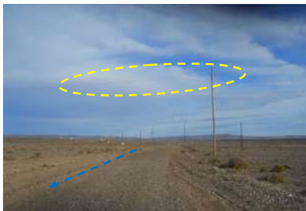
Foto III.B-57. Emplazamiento de acueducto por margen de camino. Se observa cruce con línea eléctrica (amarillo). Foto en dirección Sur.
