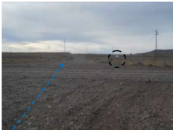
Foto III.B-54. Emplazamiento de acueducto por camino de acceso al Pozo AEA-439. Se observa cartel identificador del pozo (negro). Foto en dirección Norte.
