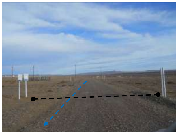
Foto III.B-55. Emplazamiento de acueducto por margen de camino. Se observa cruce con Oleoductos LC CA9 a CA3. Foto en dirección Sur.
