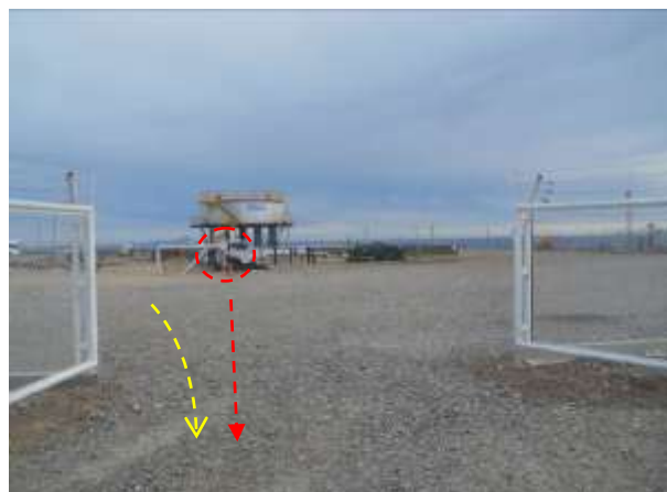
Foto III.B-4. Inicio de los ductos por camino de ingreso a la Batería LE. Foto en dirección Oeste.
