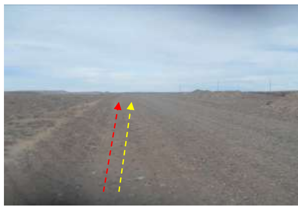
Foto III.B-6. Se observa emplazamiento de ductos por margen de camino. Foto en dirección Sur.
