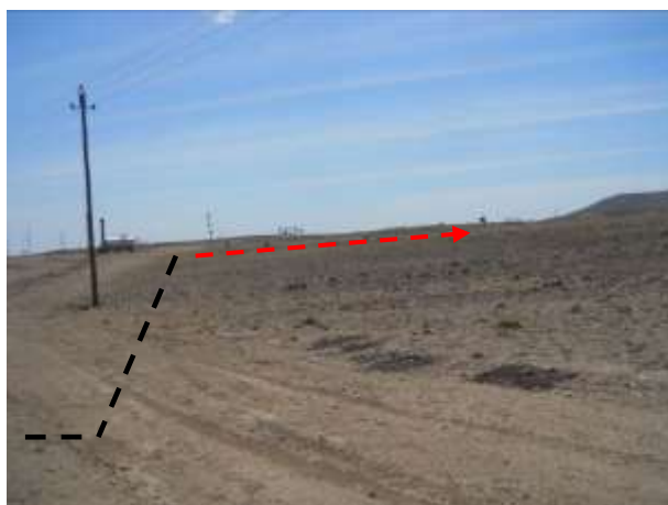
Foto III.B-37. Inicio del tramo II del oleoducto desde la futura Batería EA III (negro). Foto en dirección NE.
