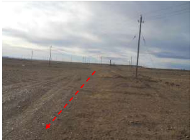
Foto III.B-40. Emplazamiento de oleoducto por picada existente. Foto en dirección Norte.
