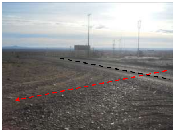
Foto III.B-47. Emplazamiento de oleoducto por camino de acceso a PTA AV. Se observa cruce con camino principal (negro) y compresora de fondo. Foto en dirección SE.
