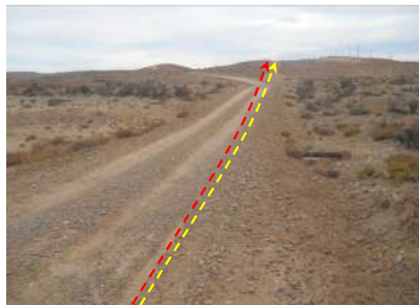
Foto III.B-14. Emplazamiento de ductos por camino principal. Foto en dirección SE.
