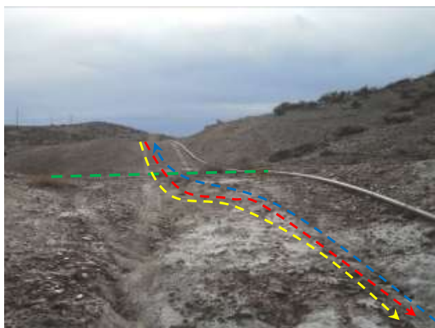
Foto III.B-73. Emplazamiento de acueducto por picada. Se observan línea de conducción emplazada, signos de erosión y cruce con drenaje efímero (verde). Se observa futuro oleoducto (rojo) y futuro gasoducto (amarillo). Foto en dirección Norte.
