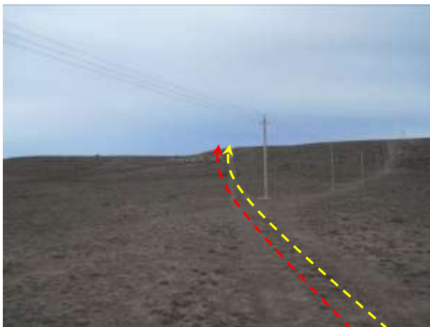
Foto III.B-27. Cruce de traza por picada con línea eléctrica. Foto en dirección Sur.
