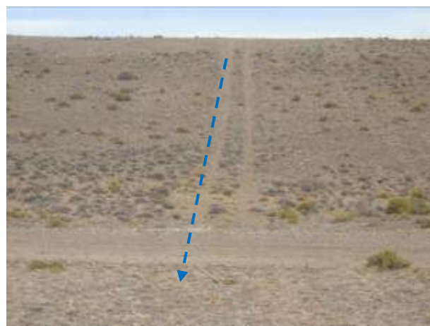
Foto III.B-60. Vista de picada por donde se emplazará el acueducto. Se observa cruce con camino principal. Foto en dirección Sur.
