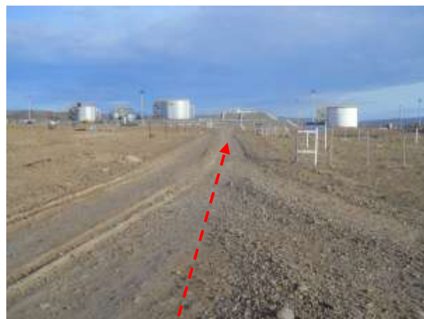
Foto III.B-48. Fin de traza de oleoducto por camino de acceso a PTA AV. Foto en dirección Sur.
