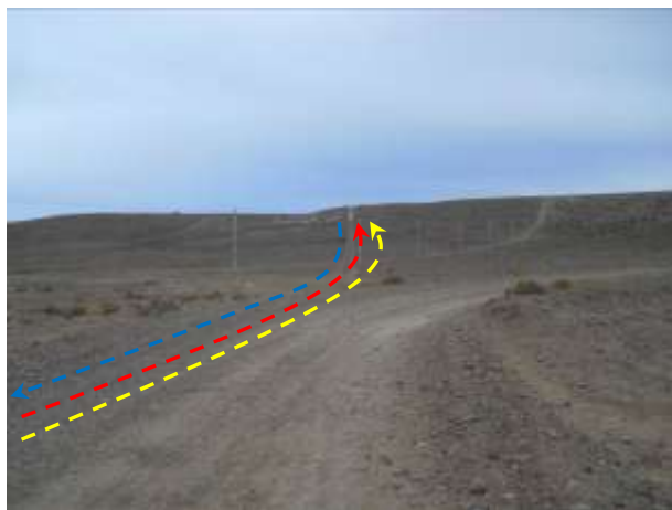
Foto III.B-65. Emplazamiento de acueducto por margen de camino. Se observa futuro oleoducto (rojo) y futuro gasoducto (amarillo). Foto en dirección Sur.
