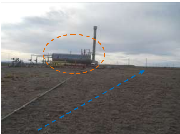
Foto III.B-53. Emplazamiento de acueducto por terreno virgen. Se observa calentador (naranja). Foto en dirección Norte.
