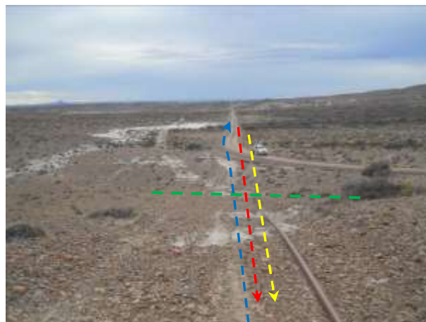
Foto III.B-68. Emplazamiento de acueducto por picada. Se observa cruce con drenaje efímero (verde) y camino principal de fondo. Se observa futuro oleoducto (rojo) y futuro gasoducto (amarillo). Foto en dirección Norte.
