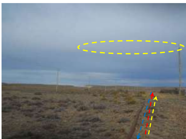
Foto III.B-71. Emplazamiento de acueducto por terreno virgen. Se observa cruce con tendido eléctrico (amarillo). Se observa futuro oleoducto (rojo) y futuro gasoducto (amarillo). Foto en dirección Sur.
