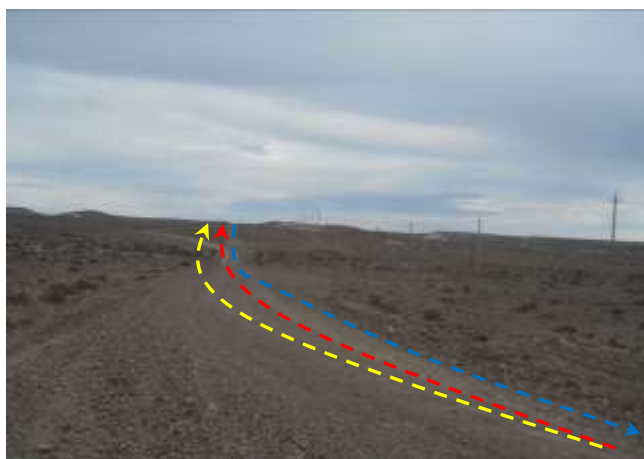
Foto III.B-77. Emplazamiento de Acueducto por margen de camino. Se observa futuro oleoducto (rojo) y futuro gasoducto (amarillo). Foto en dirección Sur.
