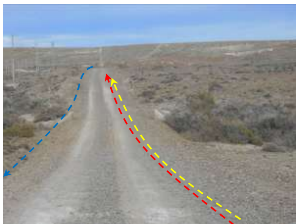
Foto III.B-69. Emplazamiento de acueducto por margen de camino. Se observa futuro oleoducto (rojo) y futuro gasoducto (amarillo). Foto en dirección Sur.
