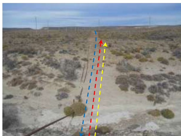
Foto III.B-72. Emplazamiento de acueducto por traza desprovista de vegetación. Se observa futuro oleoducto (rojo) y futuro gasoducto (amarillo). Foto en dirección Sur.
