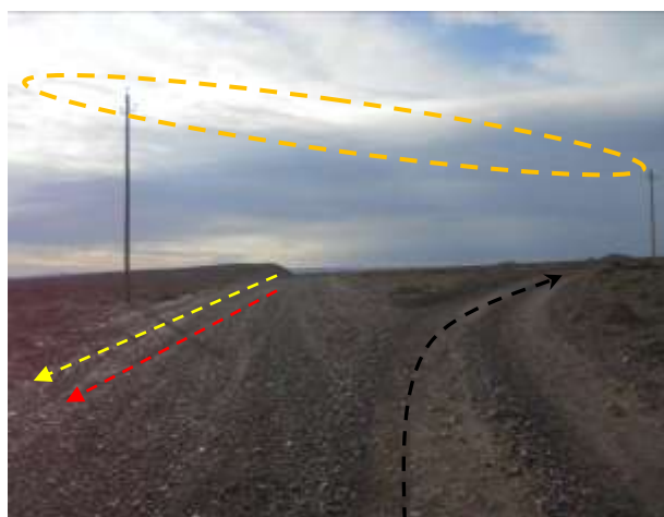
Foto III.B-33. Emplazamiento de ductos por margen de camino. Se observa cruce con línea eléctrica (naranja) y camino de acceso a estancia (negro). Foto en dirección Norte.
