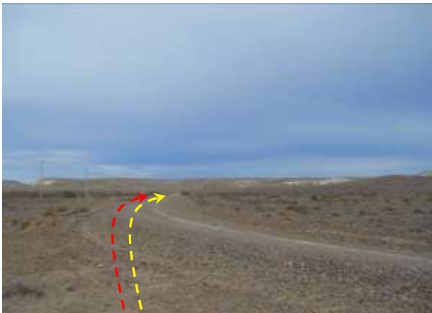
Foto III.B-21. Comienzo de emplazamiento por margen de camino. Foto en dirección Sur.
