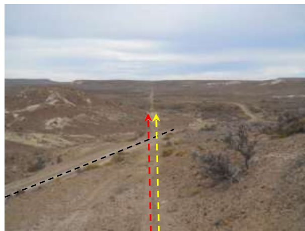
Foto III.B-16. Se observa emplazamiento de ductos por picada y cruce con camino principal. Foto en dirección Sur.
