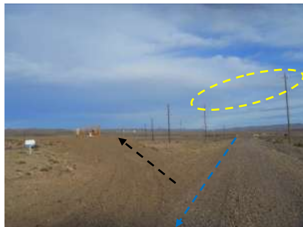
Foto III.B-56. Emplazamiento de acueducto por margen de camino. Cruce con acceso a Pozo AEA-436 (negro) y línea eléctrica (amarillo). Foto en dirección Sur.
