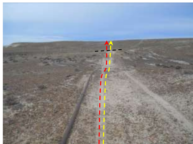
Foto III.B-24. Emplazamiento de ductos por picada hasta cruce con camino (negro). Foto en dirección Sur.
