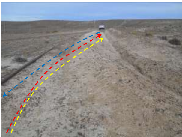
Foto III.B-67. Emplazamiento de acueducto por picada desprovista de vegetación y con signos de erosión. Se observa futuro oleoducto (rojo) y futuro gasoducto (amarillo). Foto en dirección Sur.
