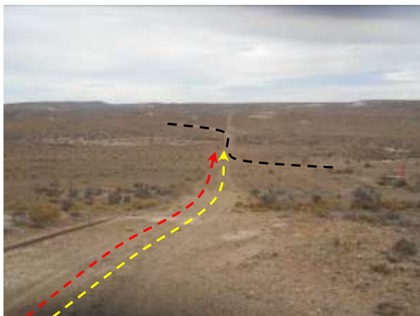
Foto III.B-13. Trazo de ductos por picada desprovista de vegetación hasta cruce con camino principal (negro). Se observa línea de conducción. Foto en dirección Sur.
