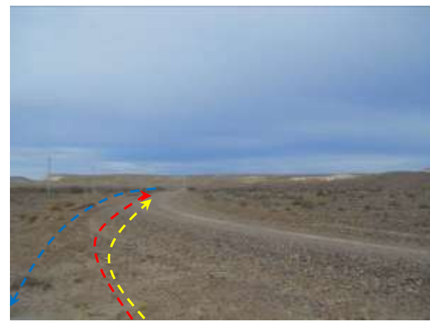
Foto III.B-70. Fin de traza por margen de camino. Comienzo por terreno virgen. Se observa futuro oleoducto (rojo) y futuro gasoducto (amarillo). Foto en dirección Sur.
