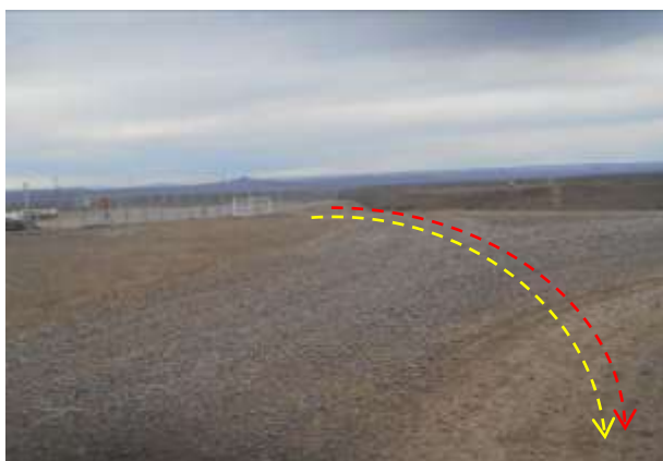
Foto III.B-5. Inicio de traza de ductos atravesando camino. Foto en dirección Norte.
