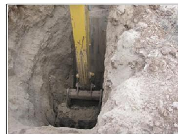
**Observaciones:** En este caso la parte superficial del perfil tiene escasa cobertura de suelo orgánico, continuando en profundidad hasta el nivel acuífero (zona saturada) un manto arenoso; que en la parte inferior (por debajo de los 2,80 m), más húmeda, carece de sustentación y se desmorona. Se obtuvieron muestras de agua para análisis físico-químicos y bacteriológicos.
