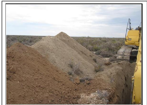
**Foto N° IV.1.3.f: Área de lagunas de tratamiento, construcción pozo de exploración.**
