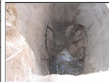
**Observaciones:** Al igual que el pozo anterior la parte superficial del perfil tiene escasa cobertura de suelo orgánico, continuando en profundidad hasta el nivel acuífero (zona saturada) un manto arenoso; que en la parte inferior (por debajo de los -3m), más húmeda, carece de sustentación y se desmorona. Se obtuvieron muestras de agua para análisis físico-químicos y bacteriológicos.
