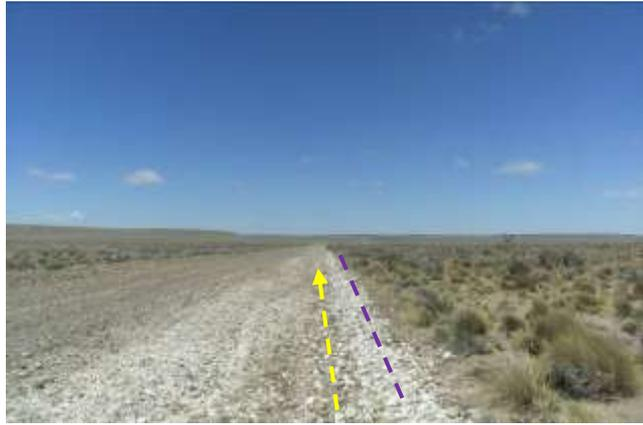
**Foto III.B-18.** Emplazamiento de gasoducto por margen interno de camino. Se observa ductos paralelos (dos oleoductos; violeta). Foto en dirección S.
