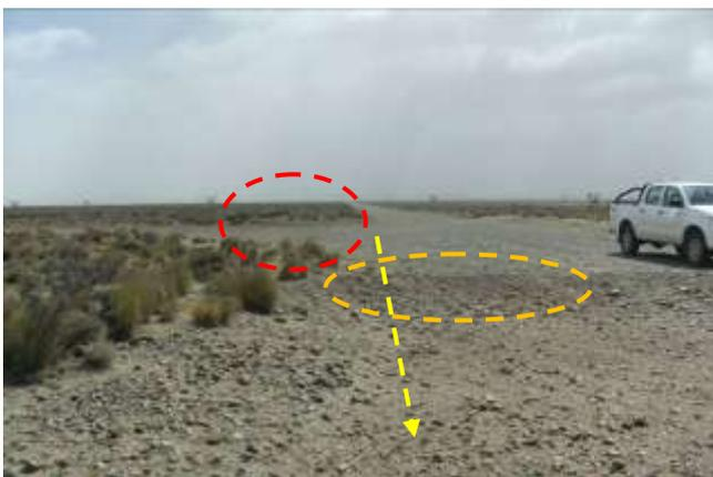
**Foto III.B-22.** Emplazamiento de gasoducto por margen interno de camino. Cruce con camino (rojo). Se observa sobremonta (anaranjado). Foto en dirección S.
