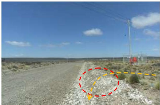
**Foto III.B-69.** Emplazamiento de oleoducto por margen interno de camino. Cruce con ducto soterrado (dos oleoductos; rojo). Foto en dirección S.
