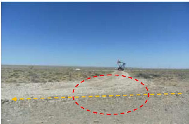
**Foto III.B-91.** Emplazamiento de oleoducto por margen interno de camino. Cruce con camino (rojo). Foto en dirección S.
