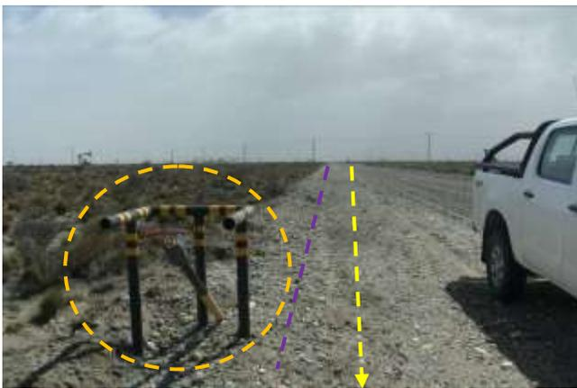
**Foto III.B-19.** Emplazamiento de gasoducto por margen interno de camino. Se observa protector de válvula (anaranjado) y ductos paralelos (dos oleoductos; violeta). Foto en dirección N.
