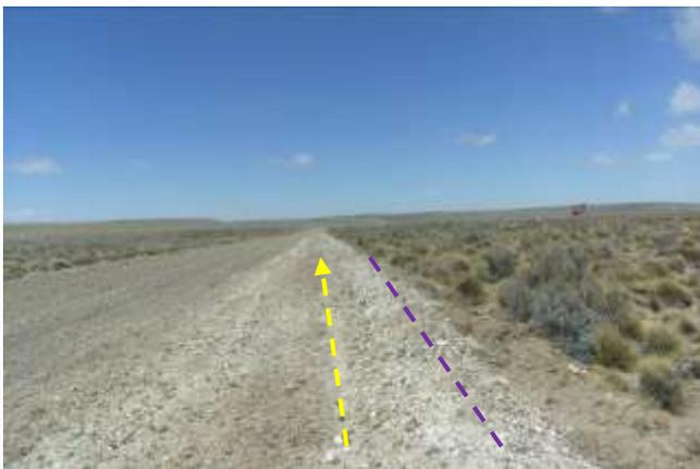
**Foto III.B-20.** Emplazamiento de gasoducto por margen interno de camino. Se observa ductos paralelos (dos oleoductos; violeta). Foto en dirección S.
