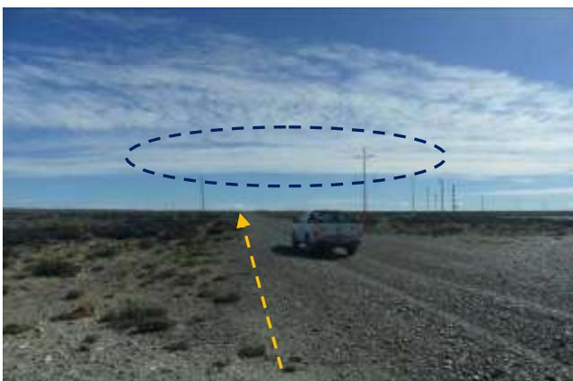
**Foto III.B-74.** Emplazamiento de oleoducto por margen interno de camino paralelo a ducto soterrado (gasoducto). Cruce con línea eléctrica (azul). Foto en dirección N.
