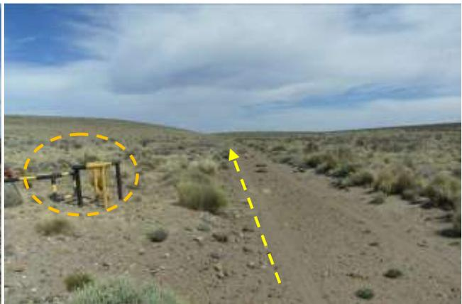
**Foto III.B-32.** Emplazamiento de gasoducto por picada existente. Se observa protector de válvula (anaranjado). Foto en dirección SSE.
