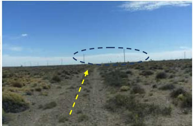
**Foto III.B-56.** Emplazamiento de gasoducto por picada existente. Cruce con línea eléctrica (azul). Foto en dirección E.
