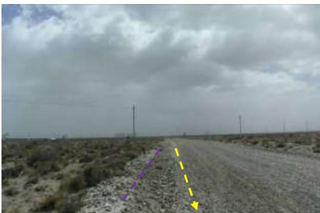
**Foto III.B-15.** Emplazamiento de gasoducto por margen interno de camino. Se observa ductos paralelos (dos oleoductos; violeta). Foto en dirección N.
