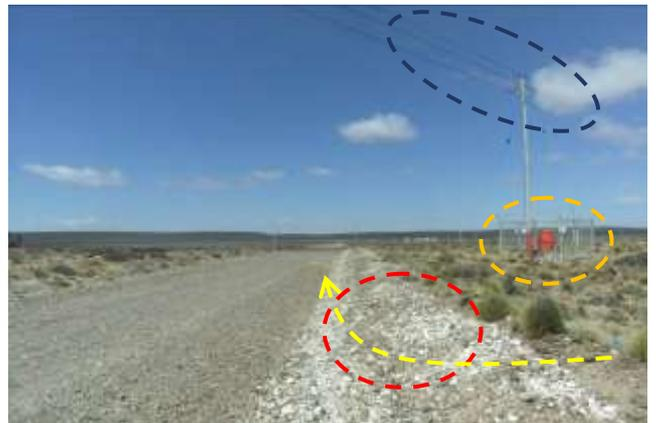
**Foto III.B-14.** Emplazamiento de gasoducto por margen interno de camino. Cruce con línea eléctrica (azul) y ducto soterrado (dos oleoductos; rojo) Se observa SET (anaranjado). Foto en dirección S.
