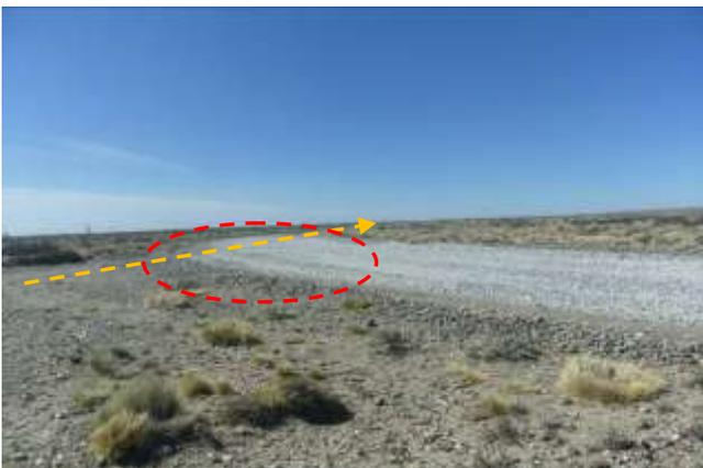
**Foto III.B-90.** Emplazamiento de oleoducto por margen interno de camino. Cruce con camino (rojo). Foto en dirección ENE.
